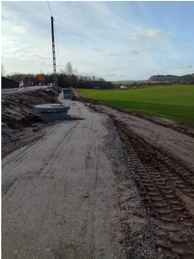
Budowa kanalizacji deszczowej.
