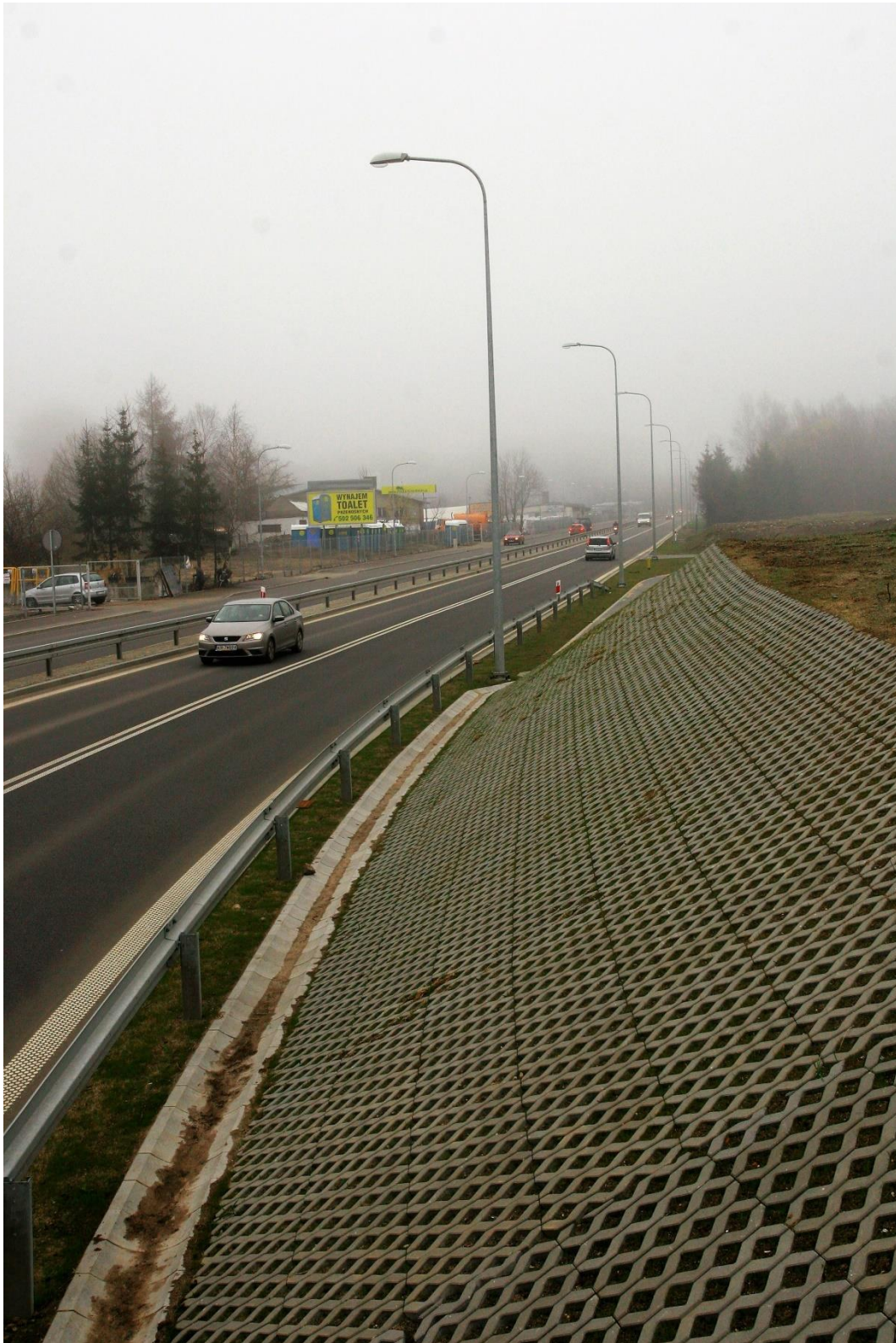
DW 224 Grzybno - Kartuzy km 5+750 nowy odcinek obwodnicy Kartuz, widok na ul. Węglową
