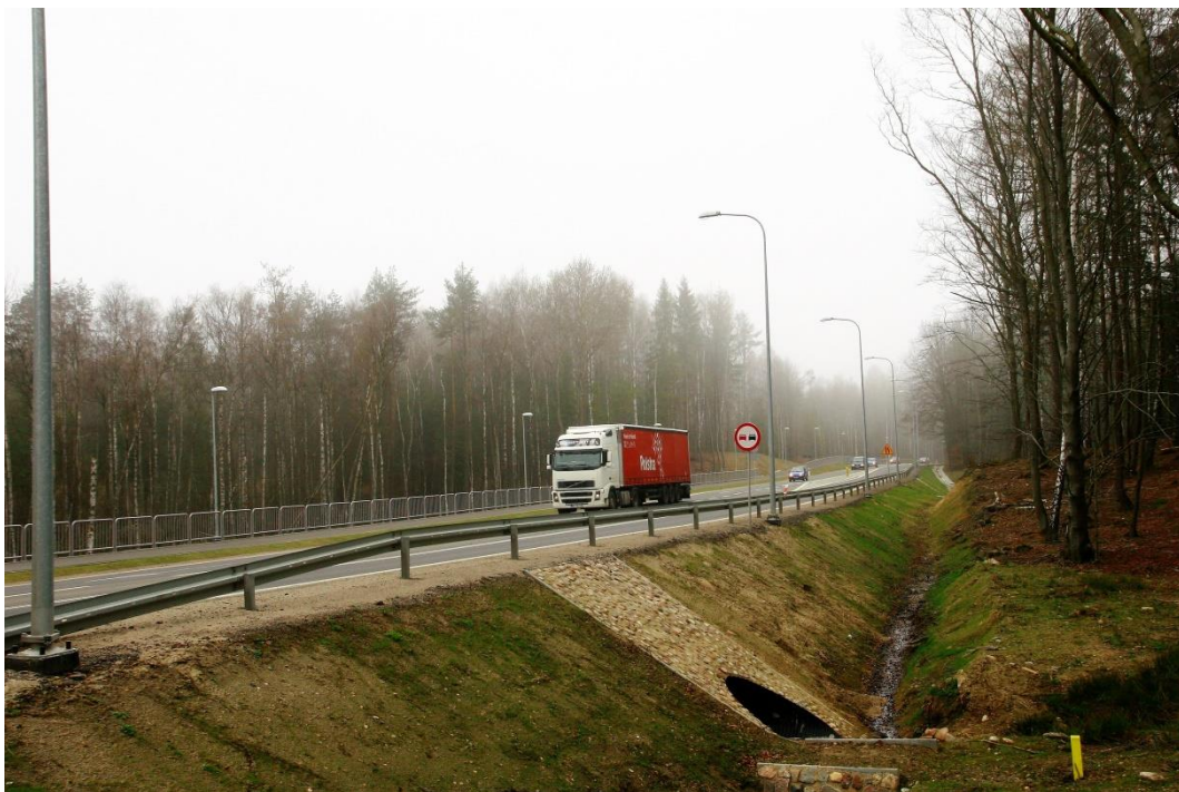
DW 224 Grzybno - Kartuzy km 4+450 przepust z przejściem dla płazów
