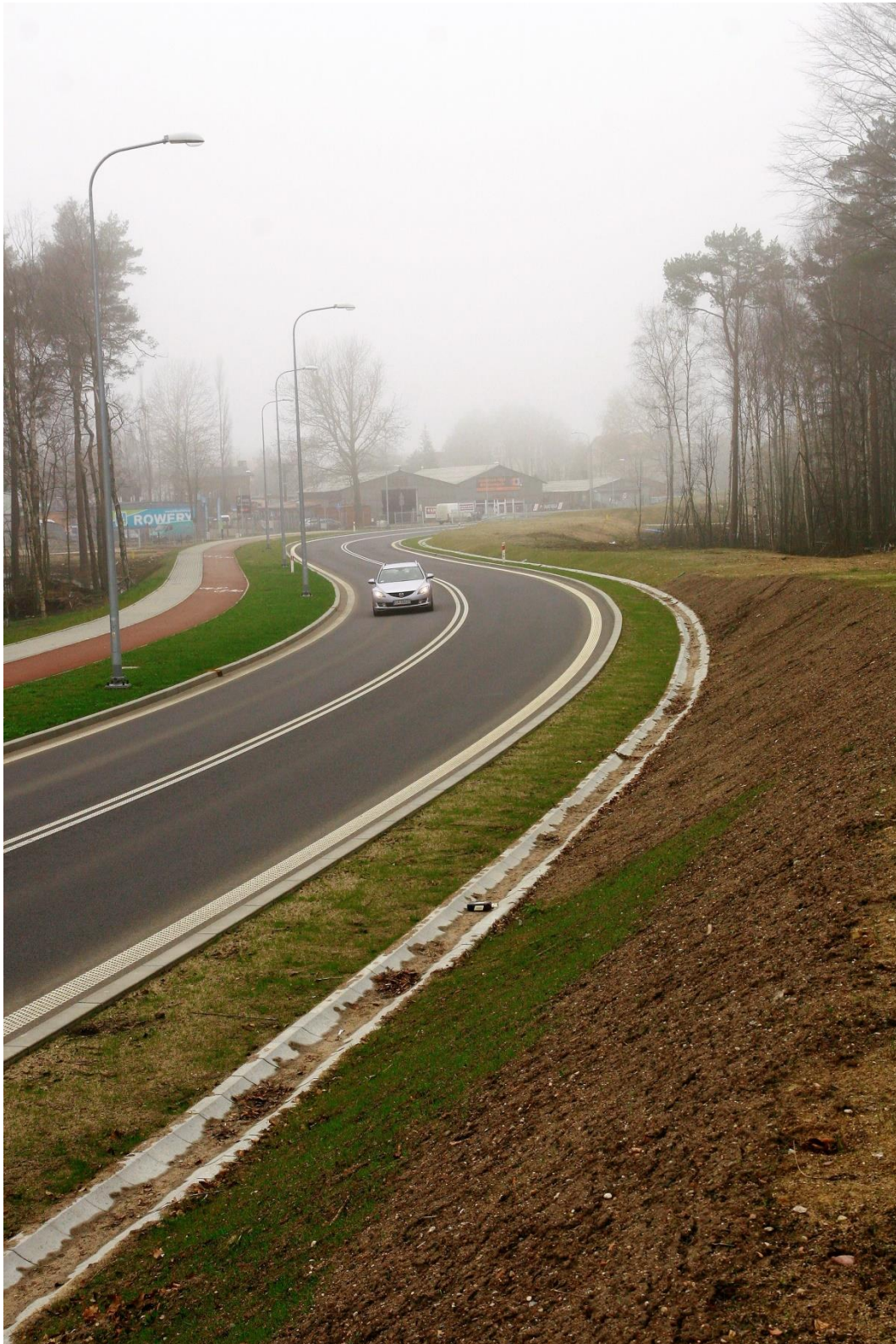
DW 224 Grzybno - Kartuzy km 5+850 nowy odcinek obwodnicy Kartuz
