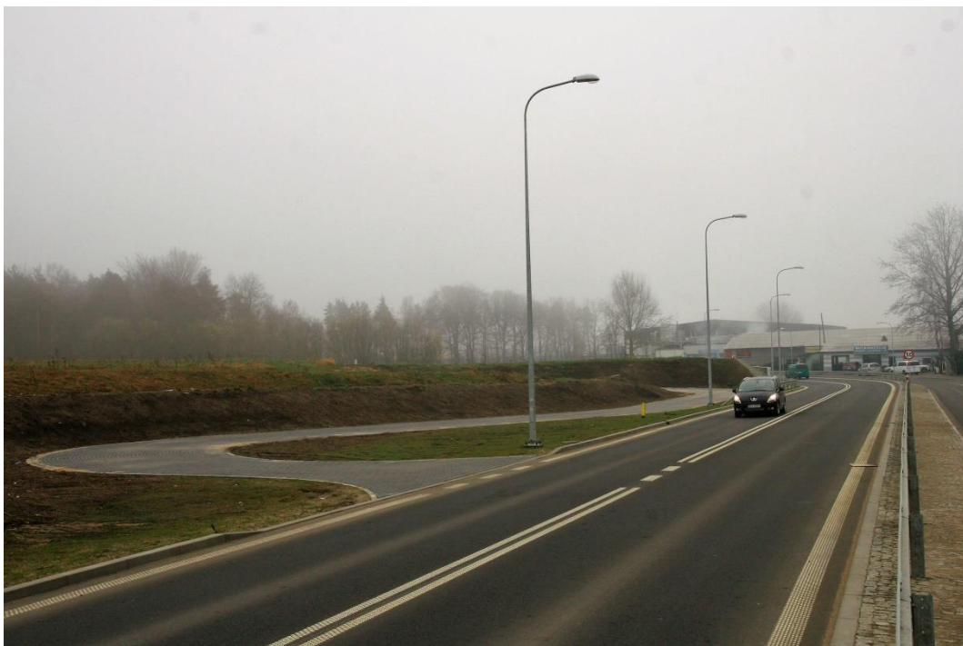
DW 224 Grzybno - Kartuzy km 5+600 nowy odcinek obwodnicy Kartuz
