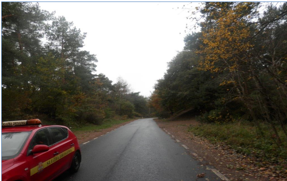
Droga wojewódzka nr 501 odc. Krynica Morska – Piaski po przebudowie
