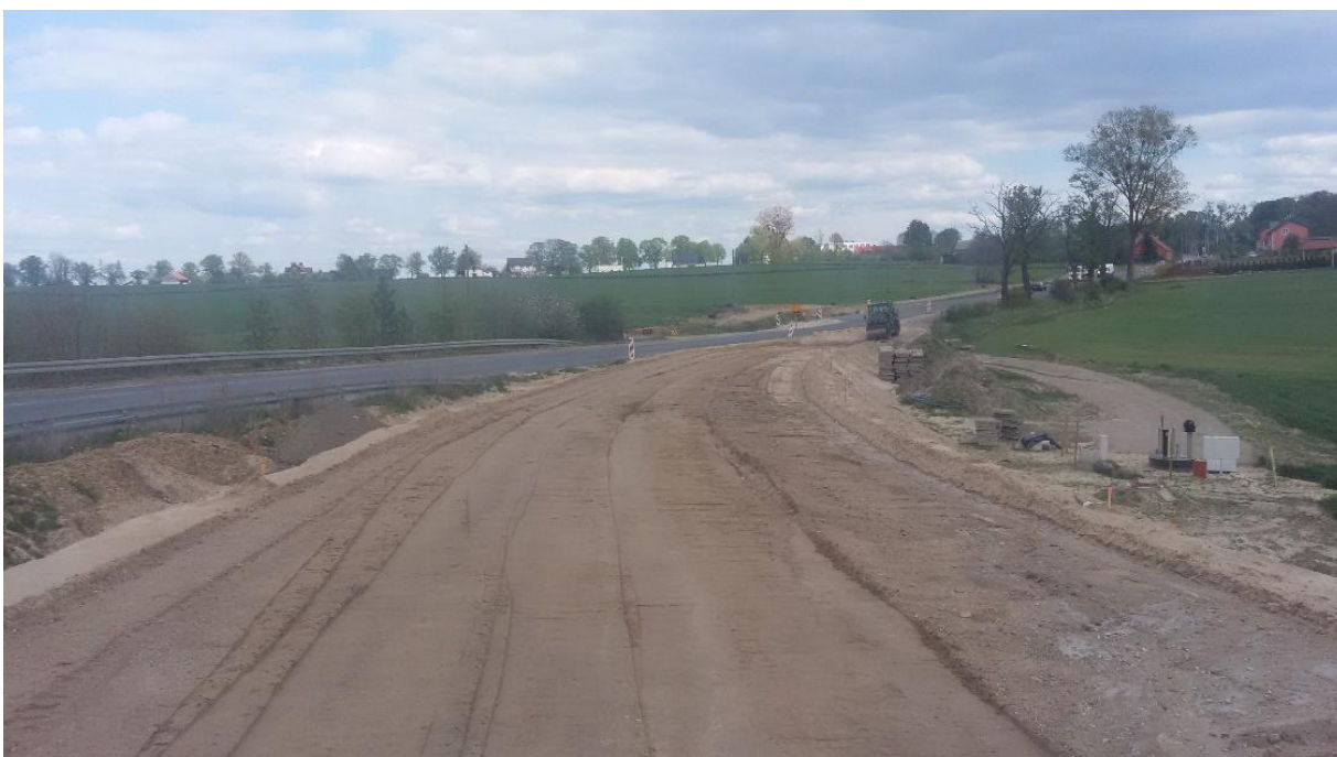
odc. Rakowiec - Licze – formowanie nasypu
