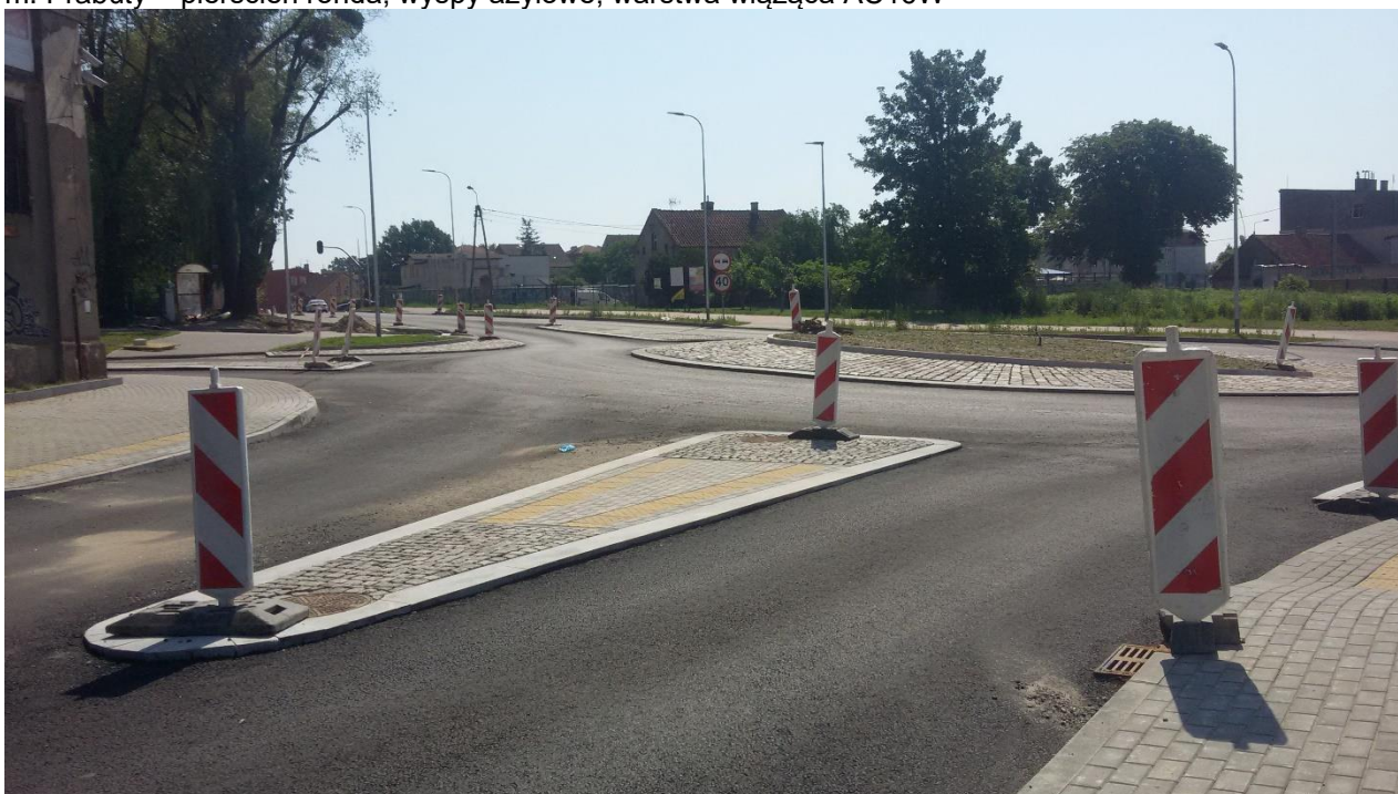
m. Prabuty – pierścień ronda, wyspy azylowe, warstwa wiążąca AC16W
