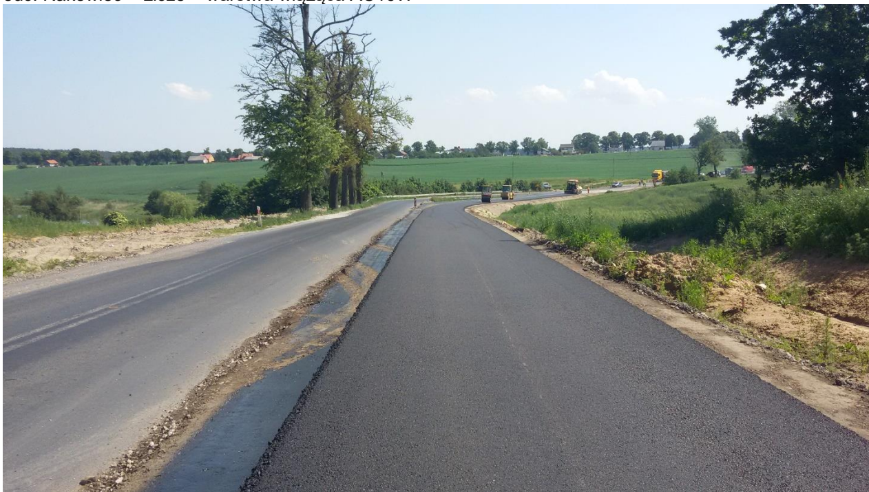
odc. Rakowiec – Licze – warstwa wiążąca AC16W
