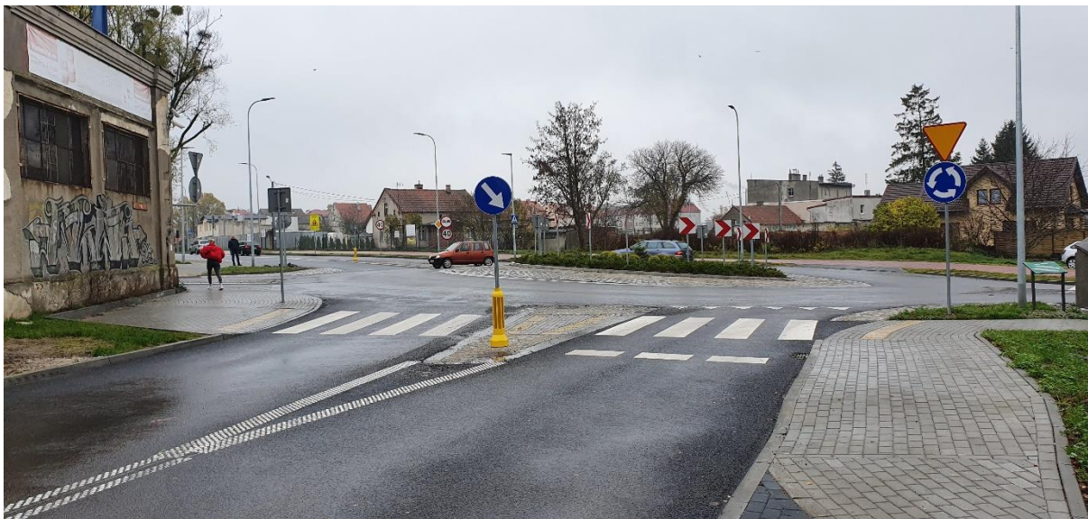
Odc. m. Prabuty; w-wa ścieralna, chodnik, oznakowanie poziome i pionowe
