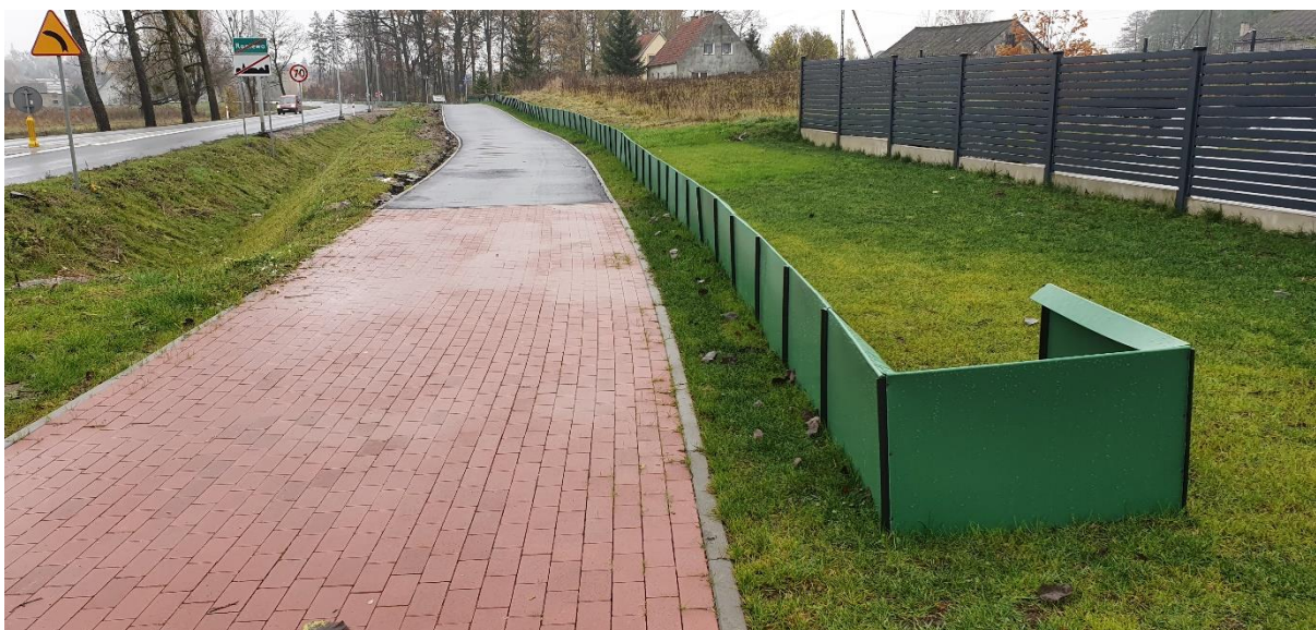
Odc. m. Raniewo; ciąg pieszo – rowerowy i wygradzenia dla płazów
