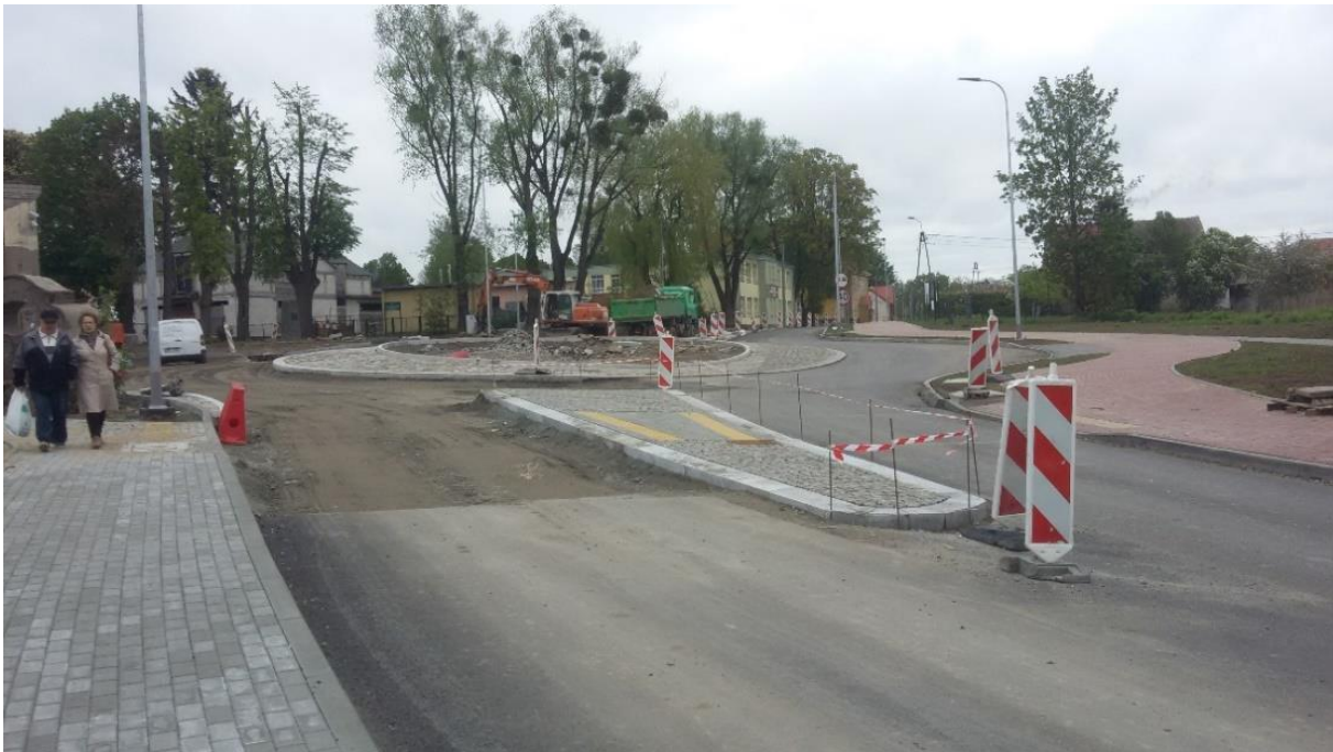
m. Prabuty – wyspa kanalizująca i azylowa, pierścień ronda
