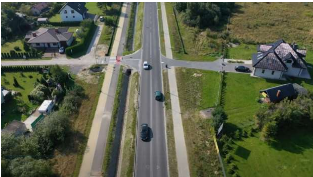
91. DW 203 – km ok. 66+300 (km proj. 9+800) Wodnica, wjazd w ul. Leśną
