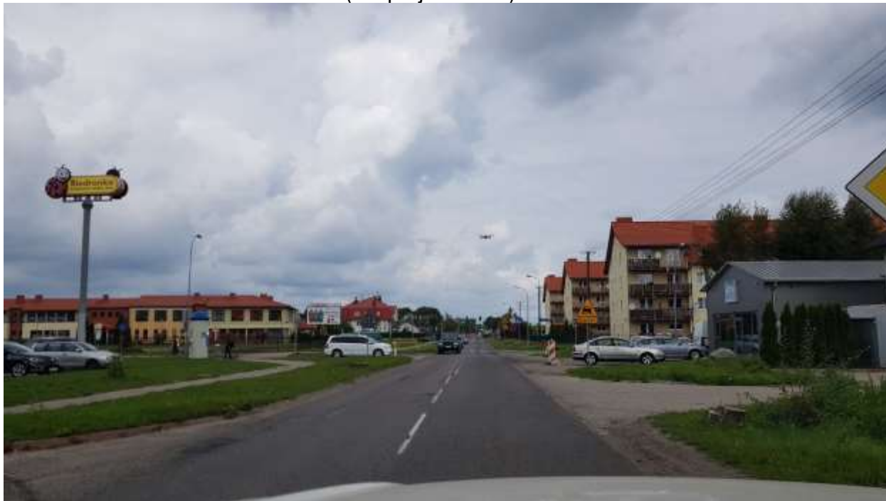
9. DW 203 – Ustka km ok. 67+400 (km proj. 10+900)
