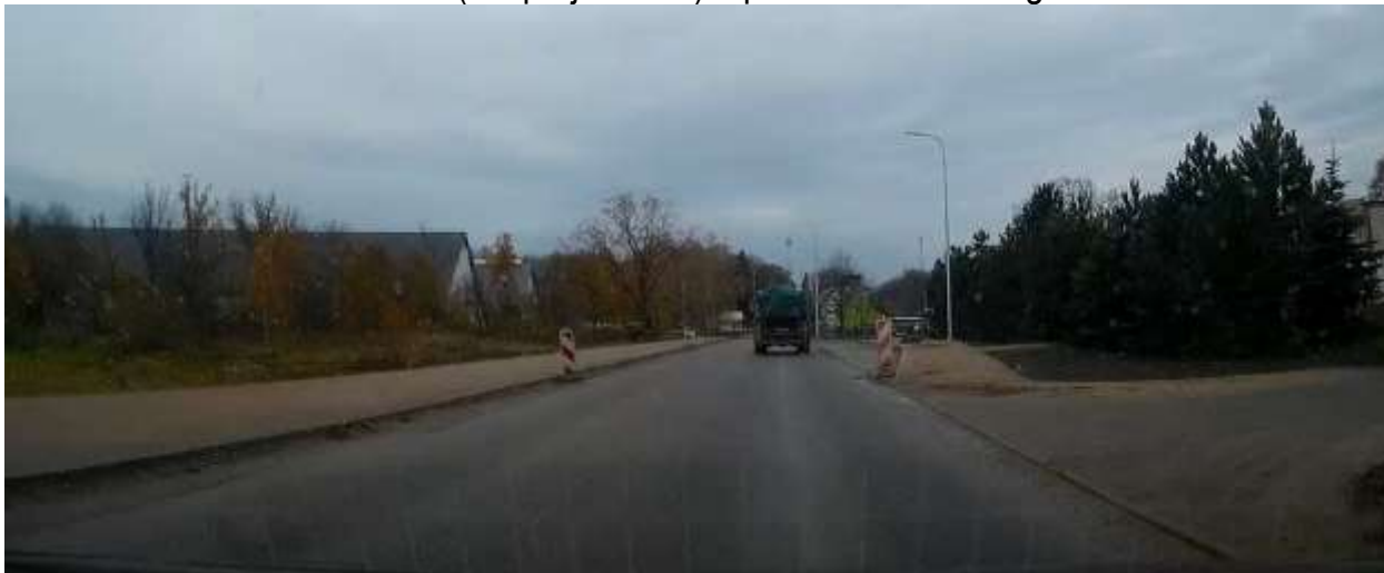
43. DW 203 – km ok. 63+250 (km proj. 7+150) – przebudowana droga w m. Duninowo
