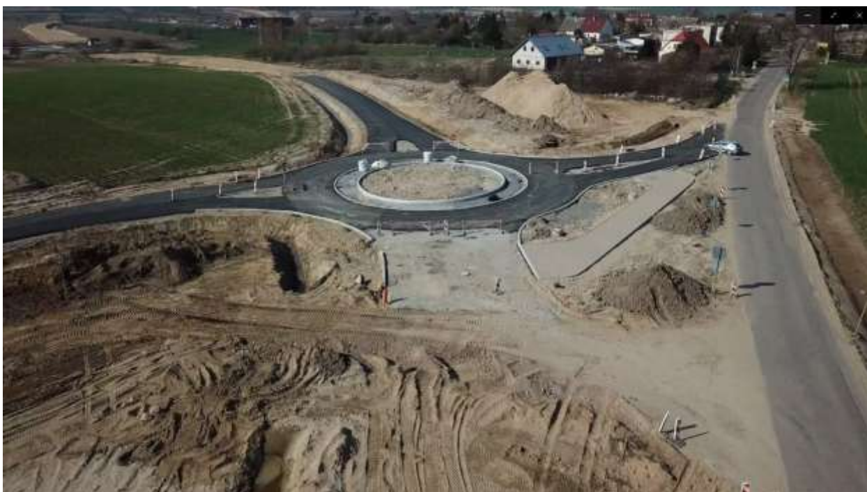
31. DW 203 – km ok. 59+100 (km proj. 2+600) rondo w m. Zaleskie
