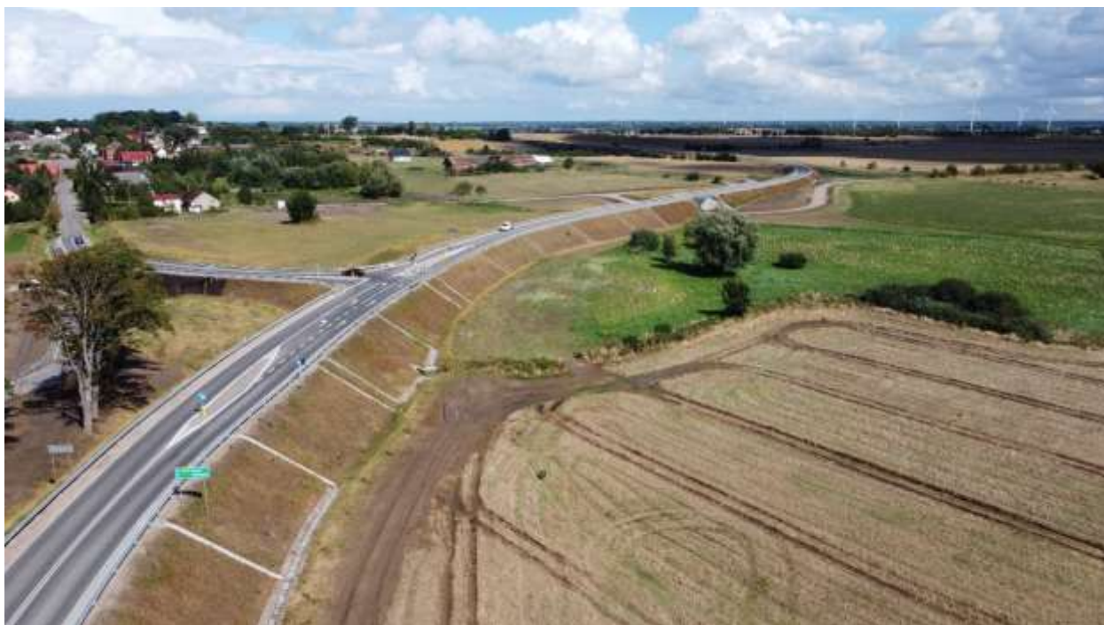
74. DW 203 – km ok. 57+800 (km proj. 1+300) Zaleskie, obwodnica
