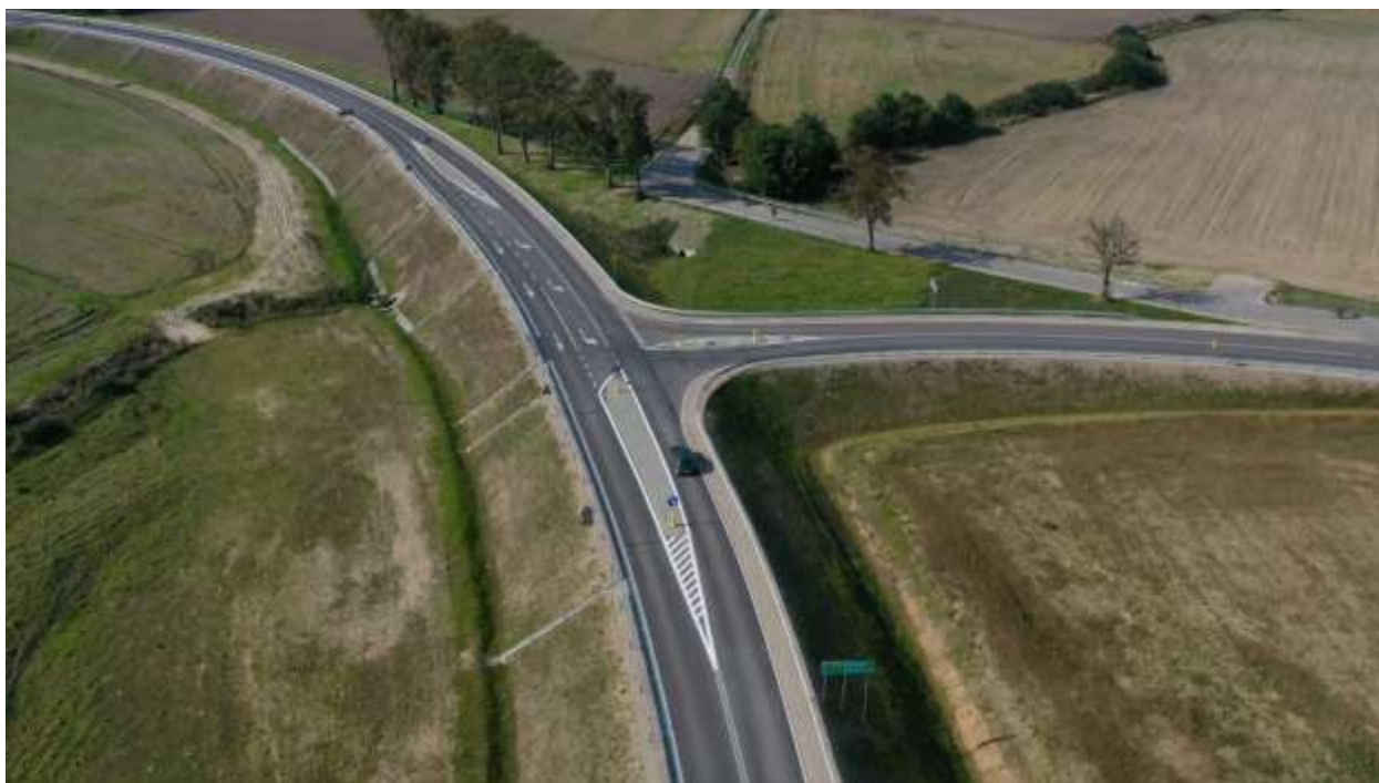
75. DW 203 – km ok. 58+000 (km proj. 1+500) Zaleskie, wjazd od str. południowej
