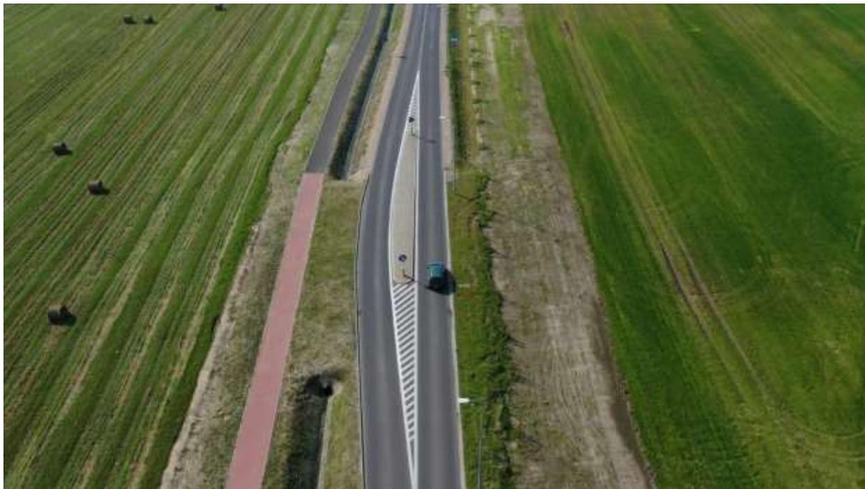
89. DW 203 – km ok. 66+000 (km proj. 9+500) Wodnica, wlot od Duninowa
