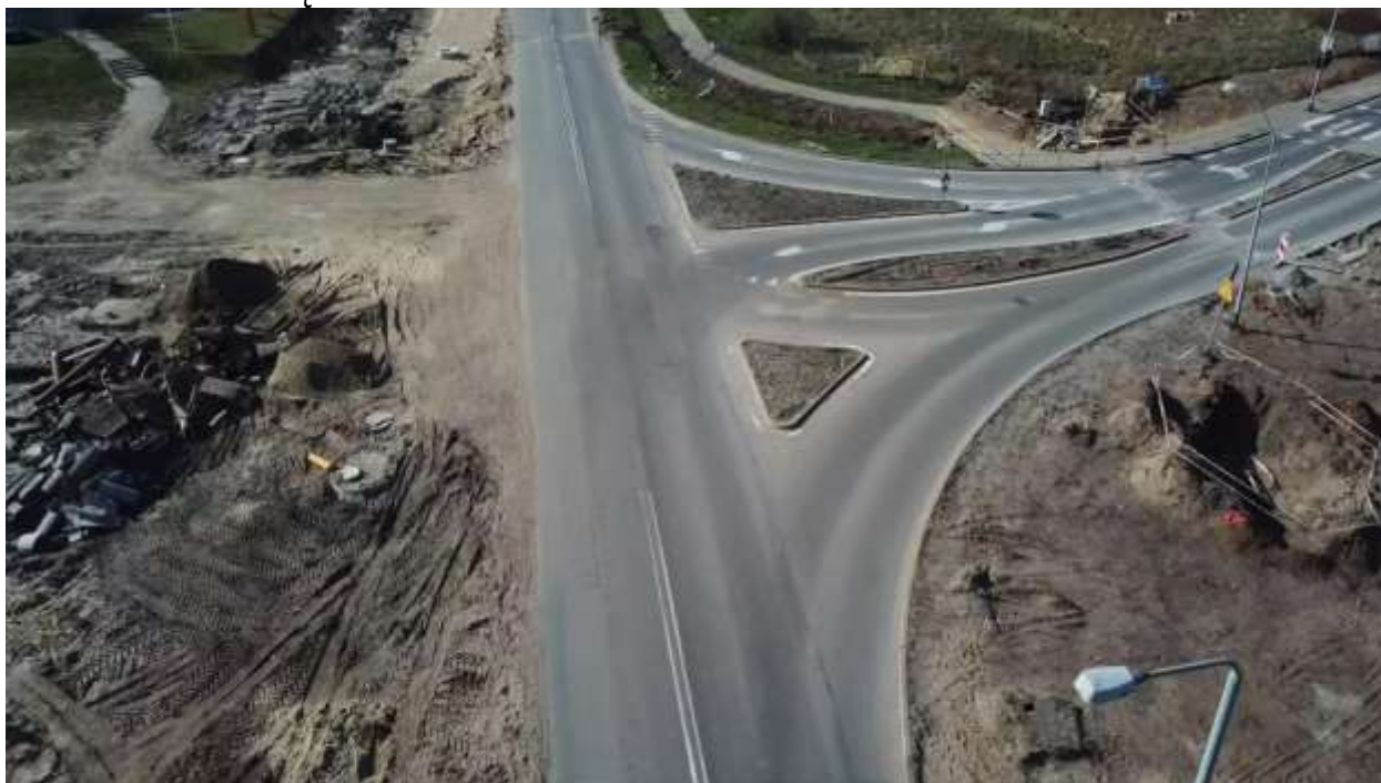
24. DW 203 – km ok. 67+750 (km proj. 11+250) ul. Darłowska skrzyżowanie z ul. Koszarową – m. Ustka
