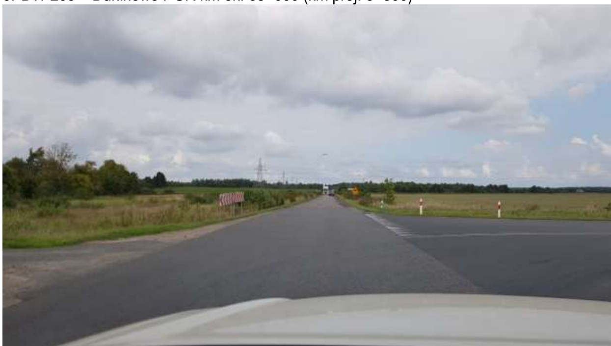
6. DW 203 – Duninowo PGR km ok. 65+000 (km proj. 8+500)
