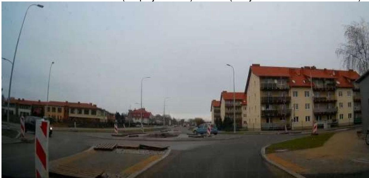
46. DW 203 – km ok. 67+450 (km proj. 10+950) – rondo (skrzyżowanie z ul. Narutowicza)
