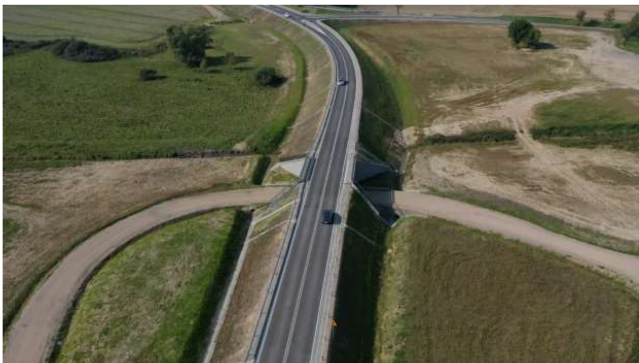
76. DW 203 – km ok. 58+150 (km proj. 1+650) Zaleskie, wiadukt na obwodnicy
