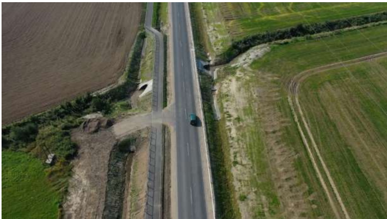
88. DW 203 – km ok. 65+500 (km proj. 9+000) Wodnica, przepust P4
