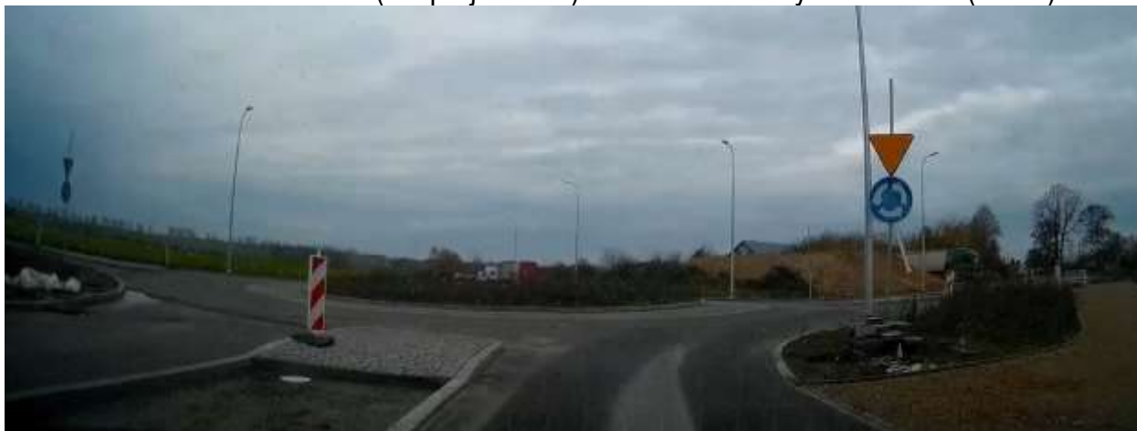
42. DW 203 – km ok. 59+100 (km proj. 2+600) koniec obwodnicy m. Zaleskie (rondo)
