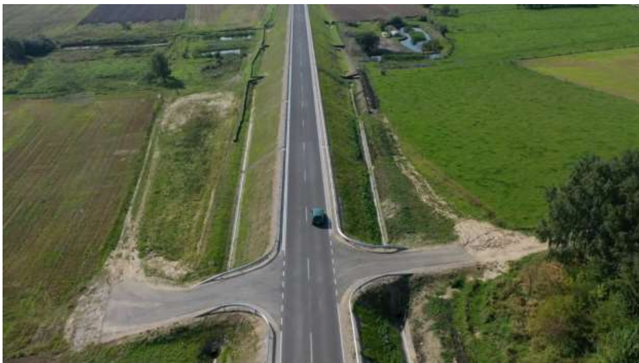
77. DW 203 – km ok. 58+800 (km proj. 2+300) Zaleskie, obwodnica
