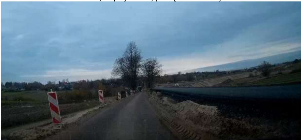
41. DW 203 – km ok. 57+700 (km proj. 1+200) początek obwodnicy m. Zaleskie
