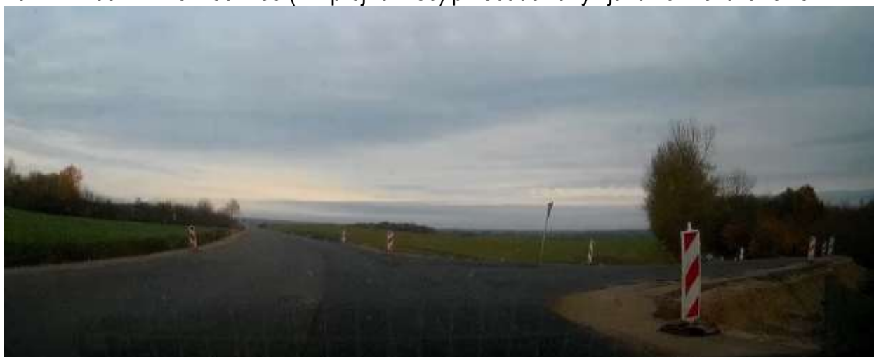
40. DW 203 – km ok. 56+750 (km proj. 0+250) przebudowany zjazd na Możdżanowo
