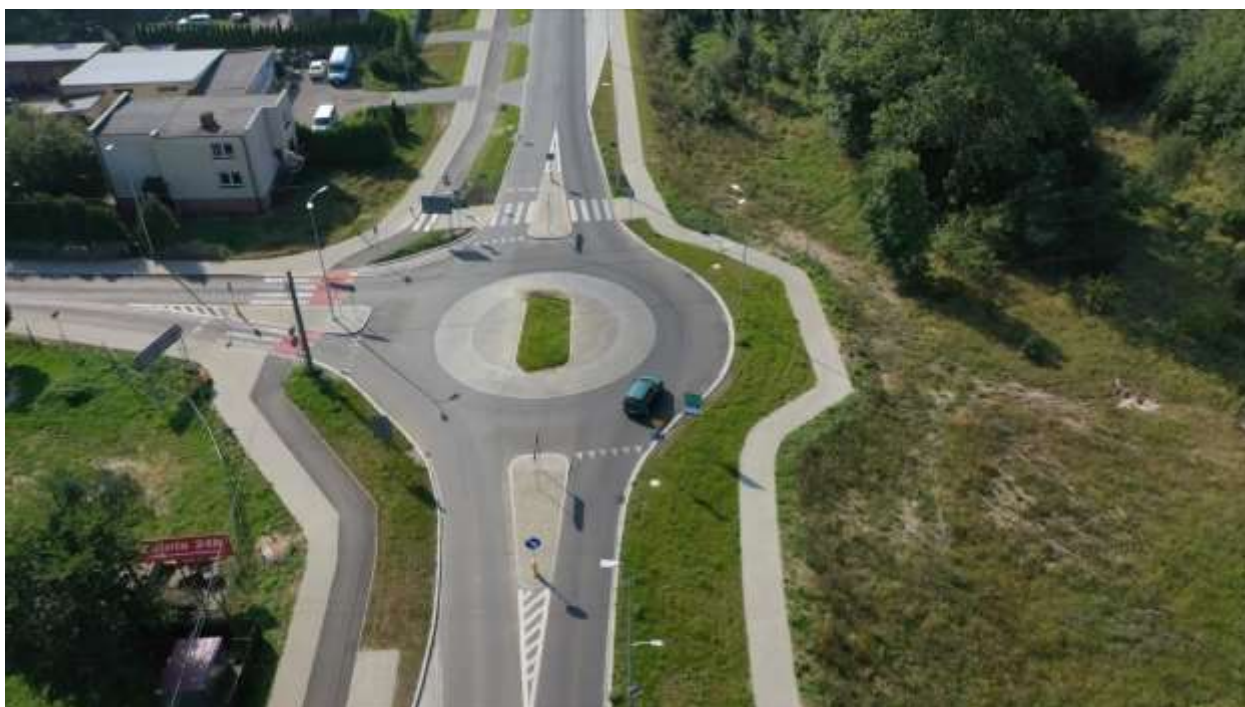
92. DW 203 – km ok. 66+800 (km proj. 10+300) Wodnica, rondo, droga do Charnowa
