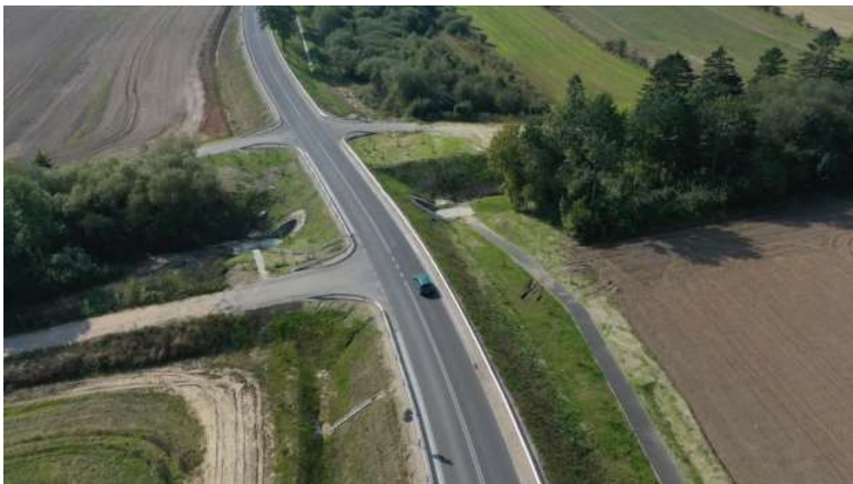
73. DW 203 – km ok. 57+700 (km proj. 1+200) Zaleskie, przepust PG1
