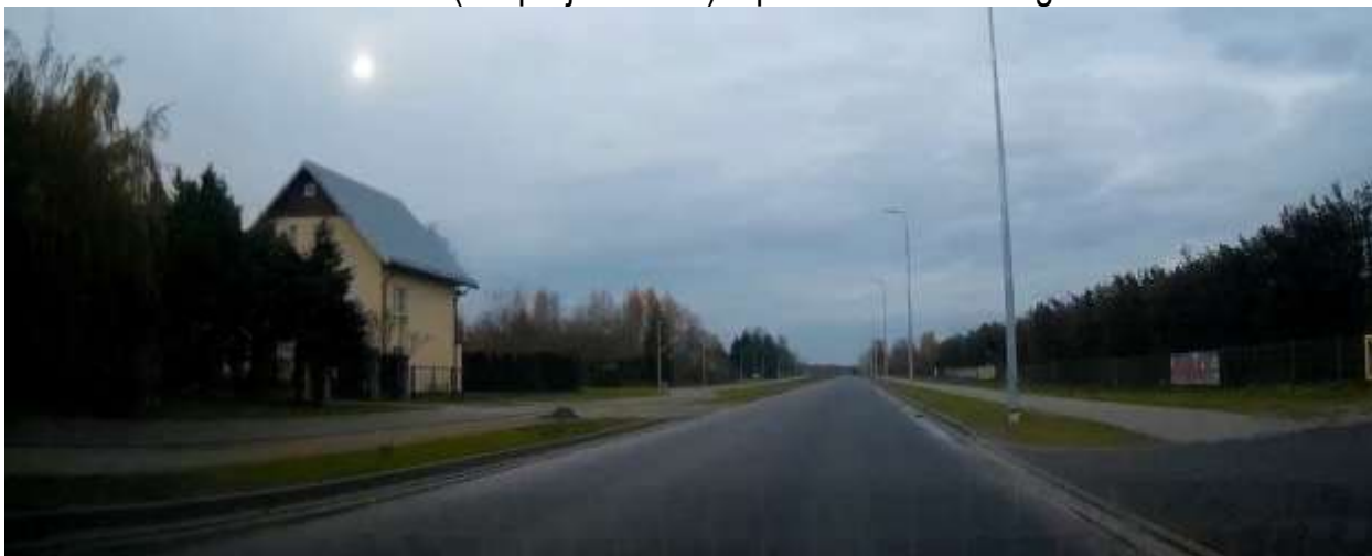
44. DW 203 – km ok. 66+500 (km proj. 10+000) – przebudowana droga w m. Wodnica
