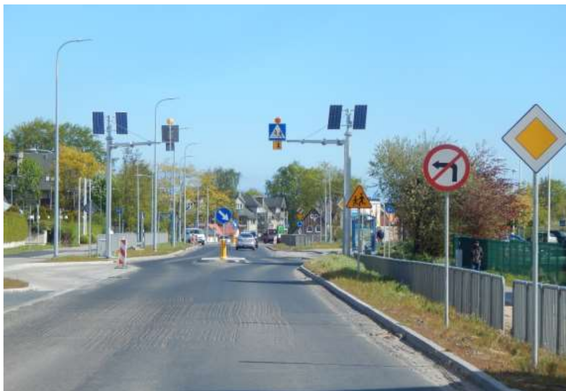
68. DW 203 – km ok. 67+500 (km proj. 11+000), Ustka, przejście koło szkoły
