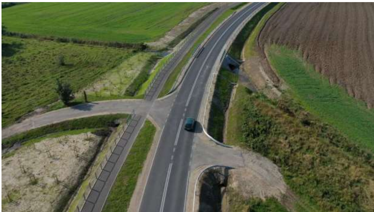
81. DW 203 – km ok. 61+700 (km proj. 5+200) przepust P3
