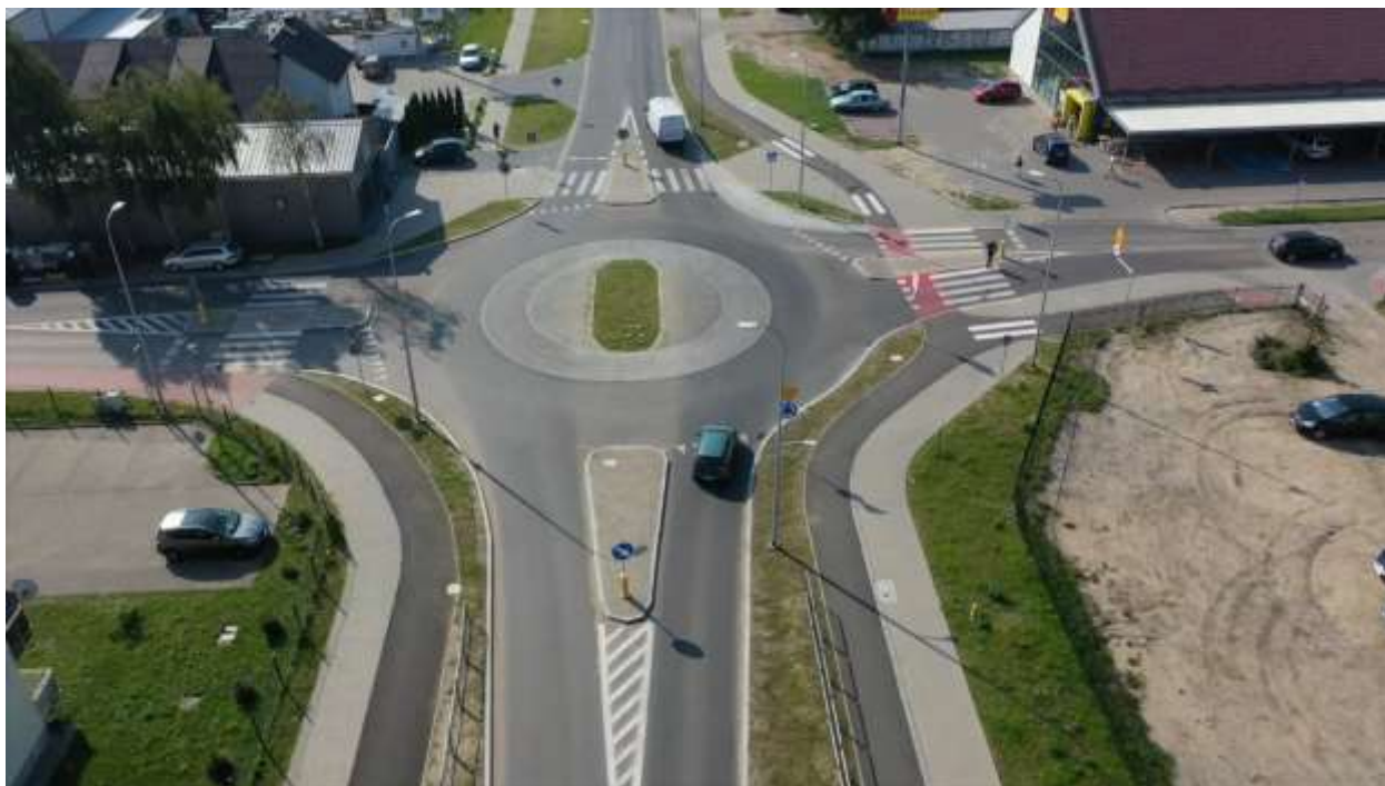
94. DW 203 – km ok. 67+450 (km proj. 10+950) Ustka, wjazd w ul. Narutowicza i Kwiatową
