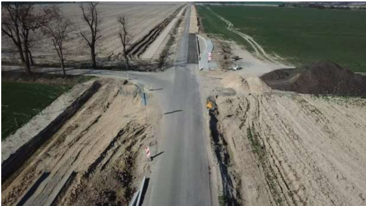
30. DW 203 – km ok. 61+100 (km proj. 4+600) skrzyżowanie do Gołęcina
