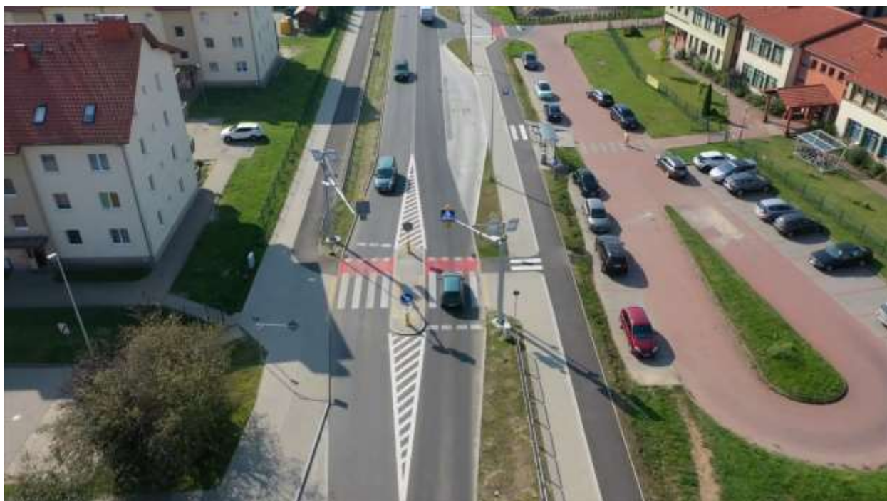
95. DW 203 – km ok. 67+600 (km proj. 11+100) Ustka, przejście koło szkoły
