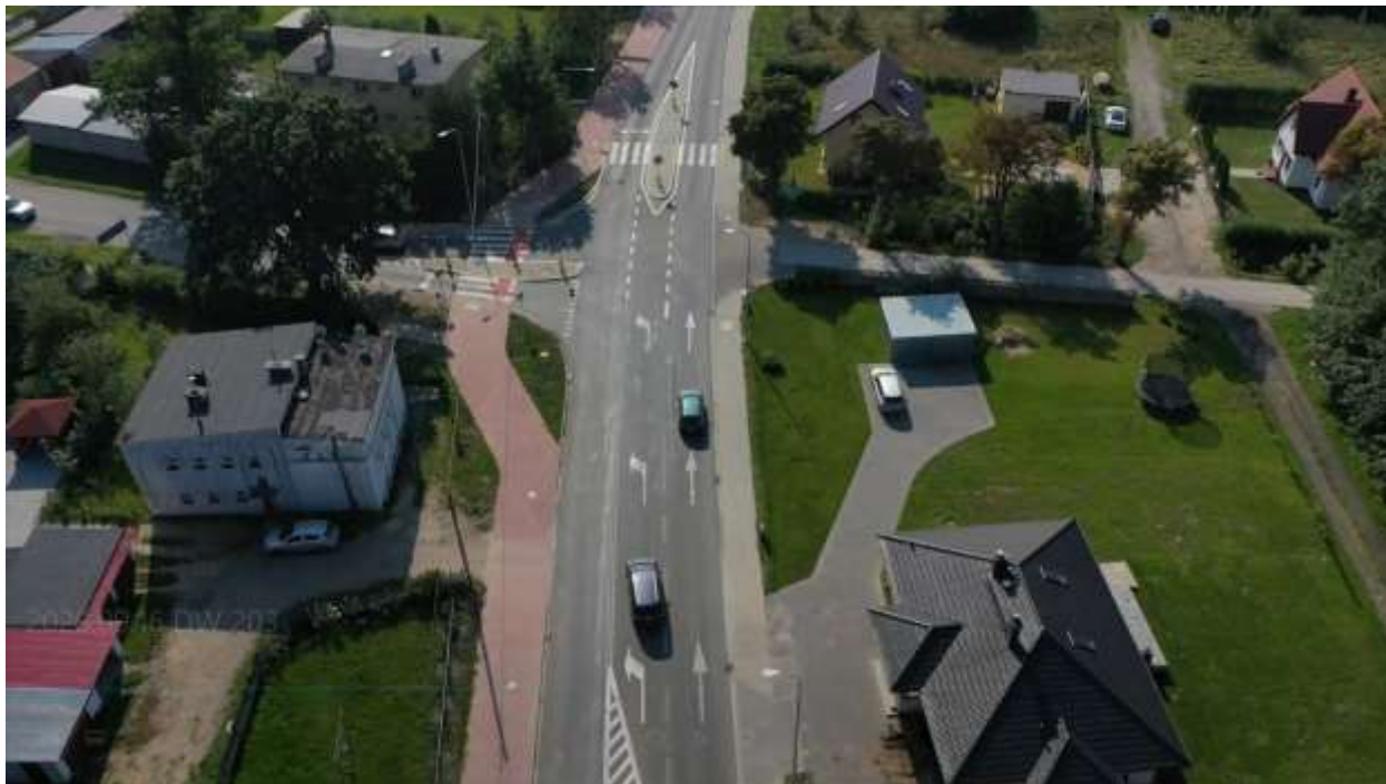
83. DW 203 – km ok. 62+950 (km proj. 6+450) Duninowo, zjazd do Bruskowa
