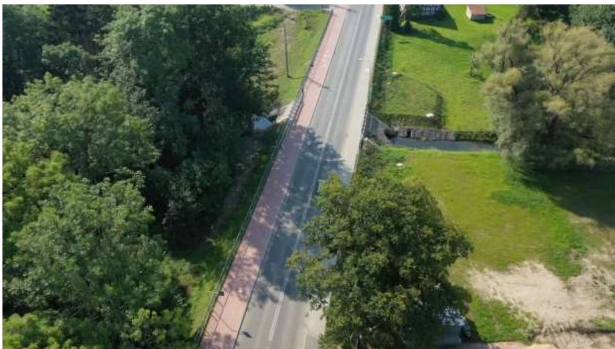
84. DW 203 – km ok. 63+250 (km proj. 6+750) Duninowo, przepust P2
