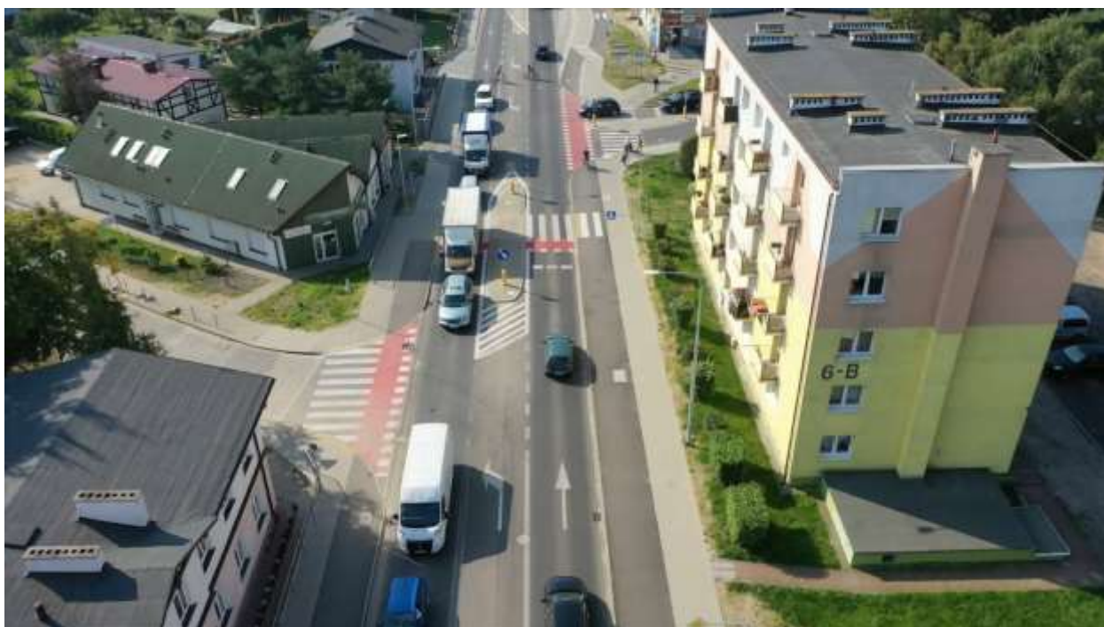
98. DW 203 – km ok. 68+100 (km proj. 11+600) Ustka, wjazd w ul. Polną
