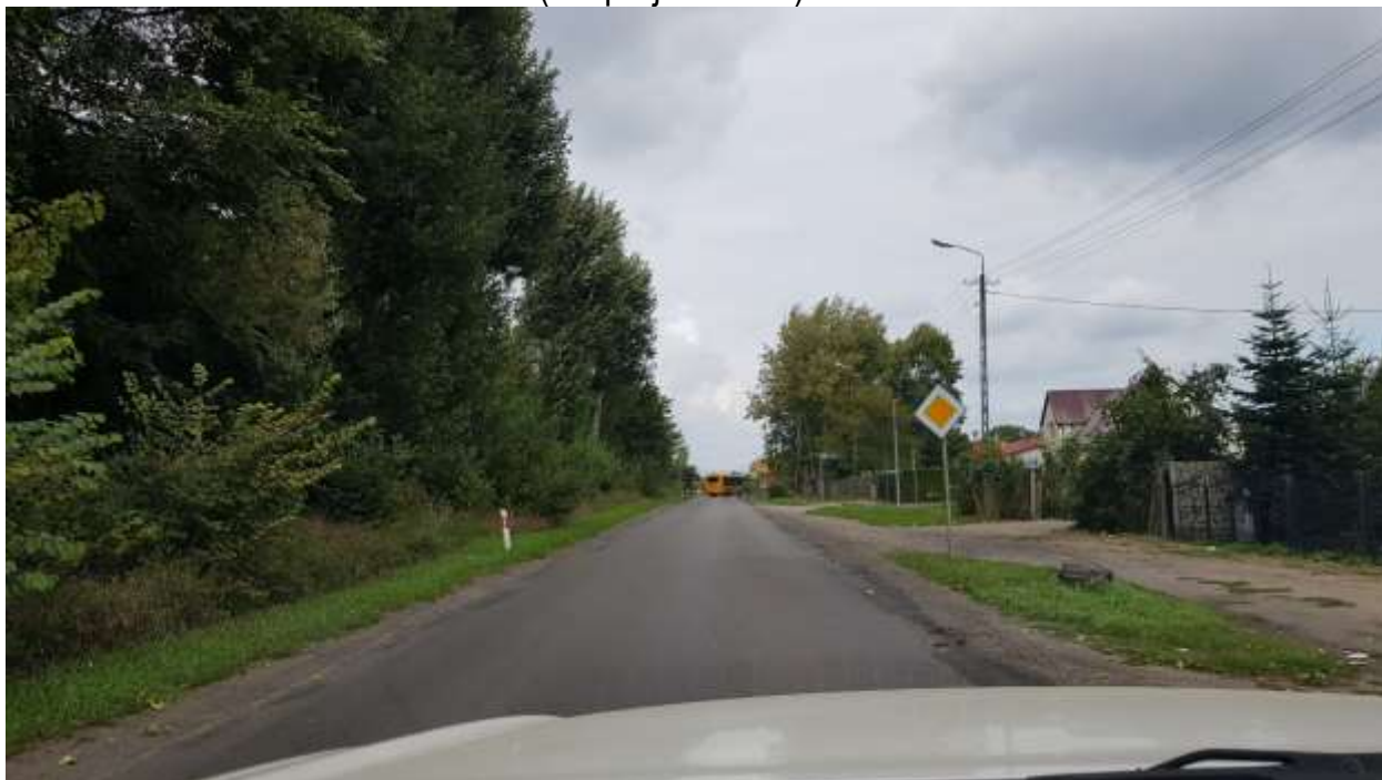
8. DW 203 – Ustka km ok. 66+900 (km proj. 10+400)
