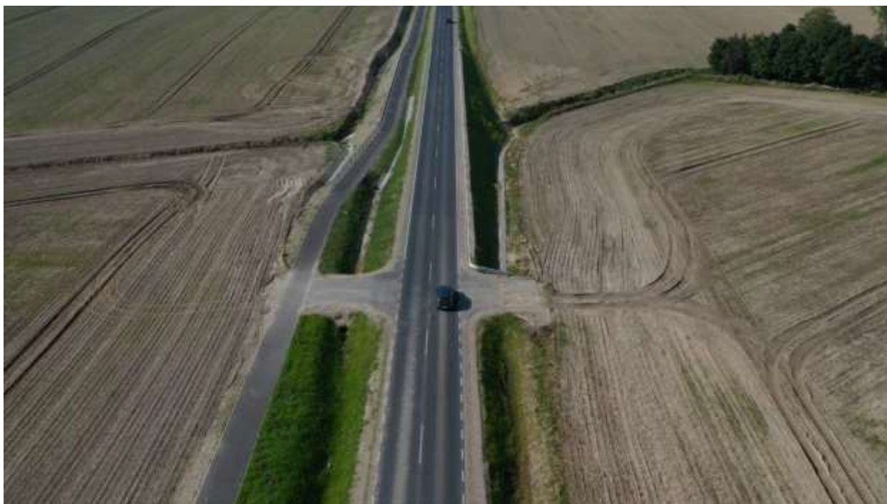
79. DW 203 – km ok. 60+050 (km proj. 3+550) Zaleskie, zjazdy na pola
