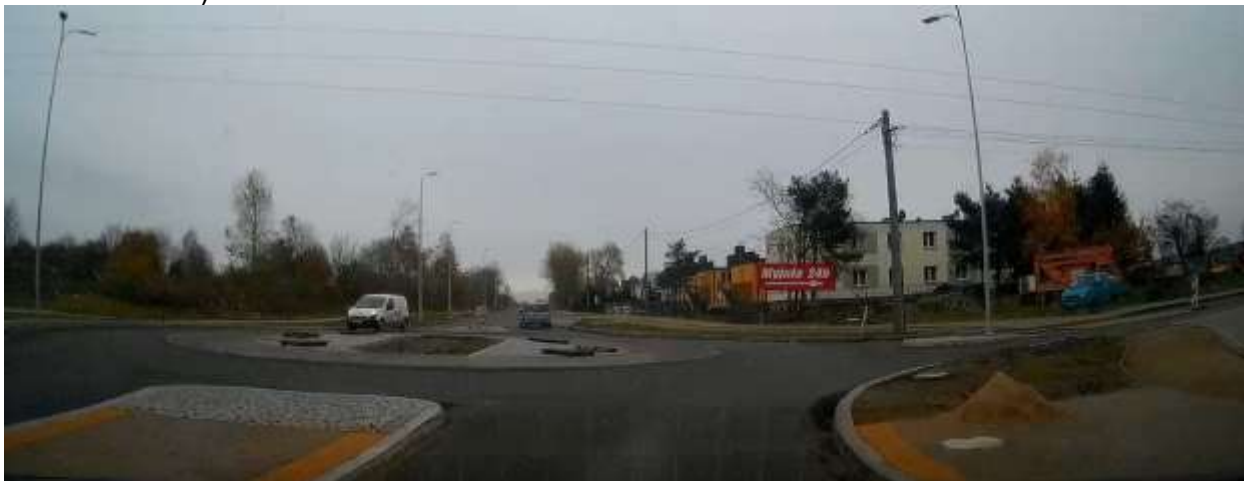
45. DW 203 – km ok. 66+800 (km proj. 10+300) – rondo w m. Wodnica (droga do Charnowa)
