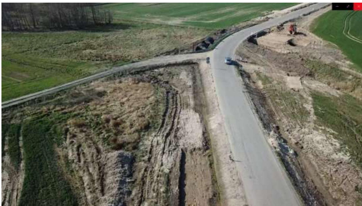
29. DW 203 – km ok. 61+600 (km proj. 5+100) przepust P-3 – m. Starkowo
