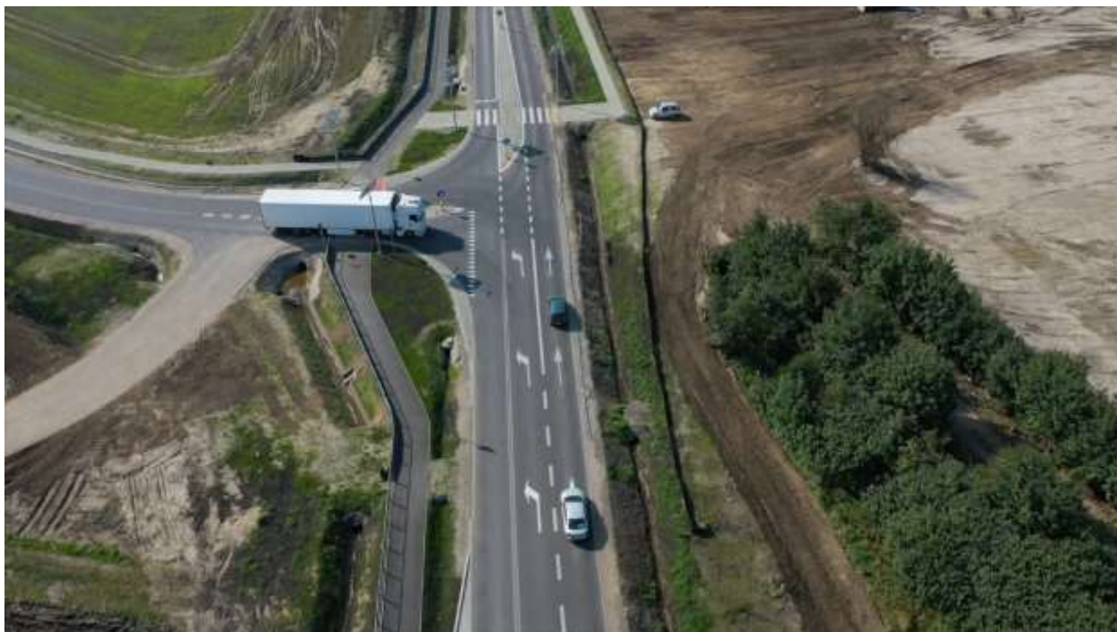
87. DW 203 – km ok. 65+050 (km proj. 8+550) Duninowo, droga do MOWI
