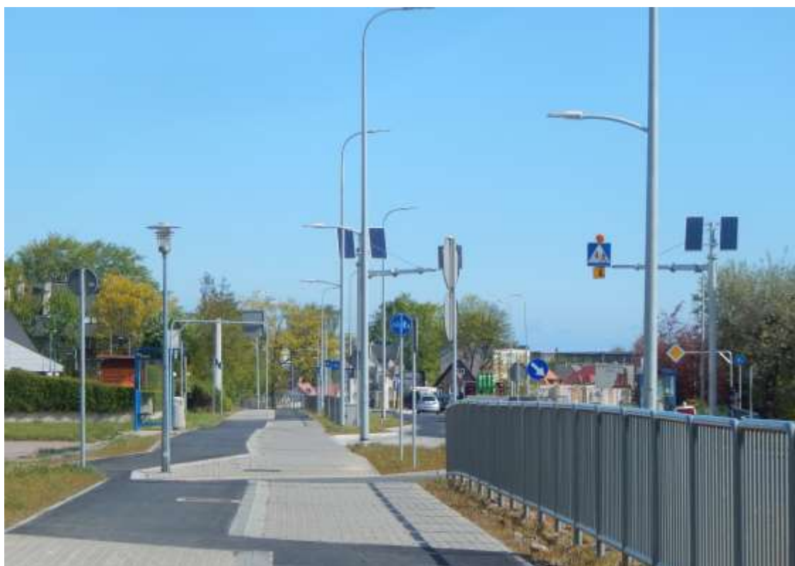
67. DW 203 – km ok. 67+500 (km proj. 11+000), Ustka, ścieżka koło szkoły
