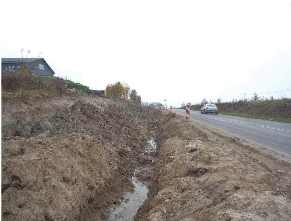
20.10.2017r. Odc. A. 0+670. Urobek z wykopu pod wodociąg. Sączenie wody.
