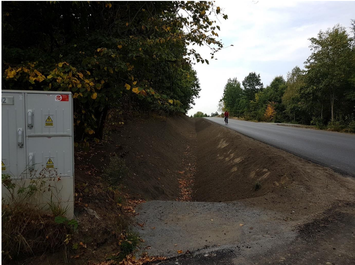
31.08.2019 Odc. C Humusowanie
