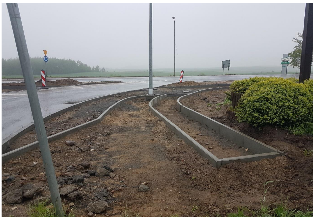
31.05.2019 Odc. F Roboty brukarskie
