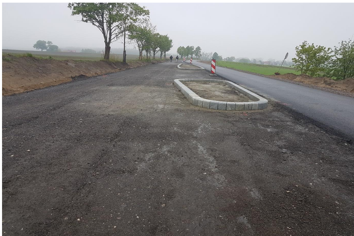
31.05.2019 Odc. C Wykonywanie warstwy podbudowy zasadniczej MCE, wysp rozdzielających
