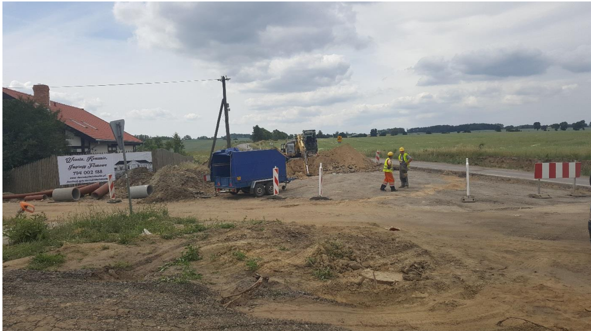
30.06.2018 r. Odc. E Budowa kanalizacji deszczowej km 1+050
