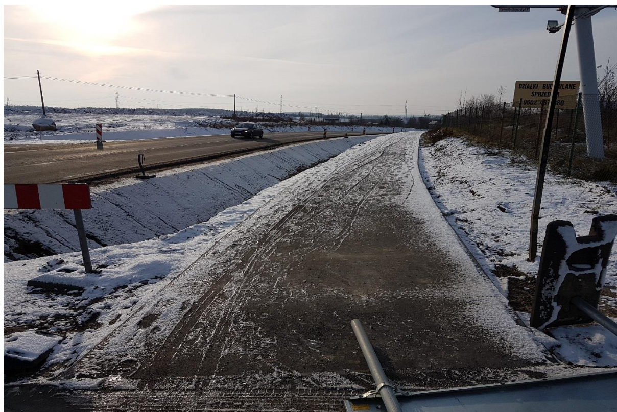
29.11.2018 Odc. A Ułożona nawierzchnia ścieżki rowerowej km 0+400
