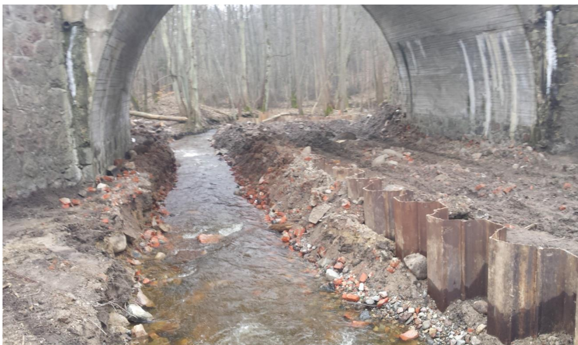
26.03.2018 r. Odc. B Roboty przygotowawcze przy przepustach dla płazów w km 4+950 do 5+050
