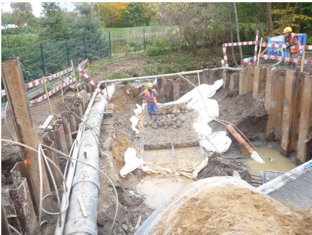
18.10.2017r. Odc. C. 0+067. Gabiony przy wylocie przepustu.
