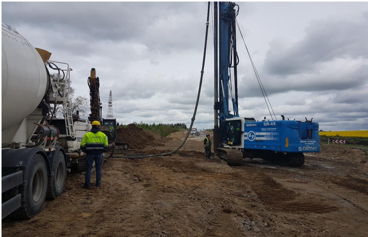
31.05.2019 Odc. B Wykonywanie w głębokiego wzmocnienia podłoża gruntowego – palowanie w km ok. 5+000
