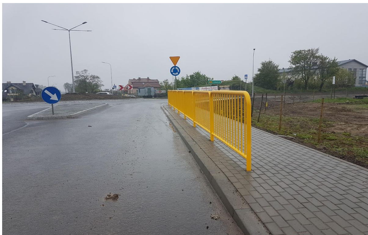
31.05.2019 Odc. A Montaż balustrad U-11a
