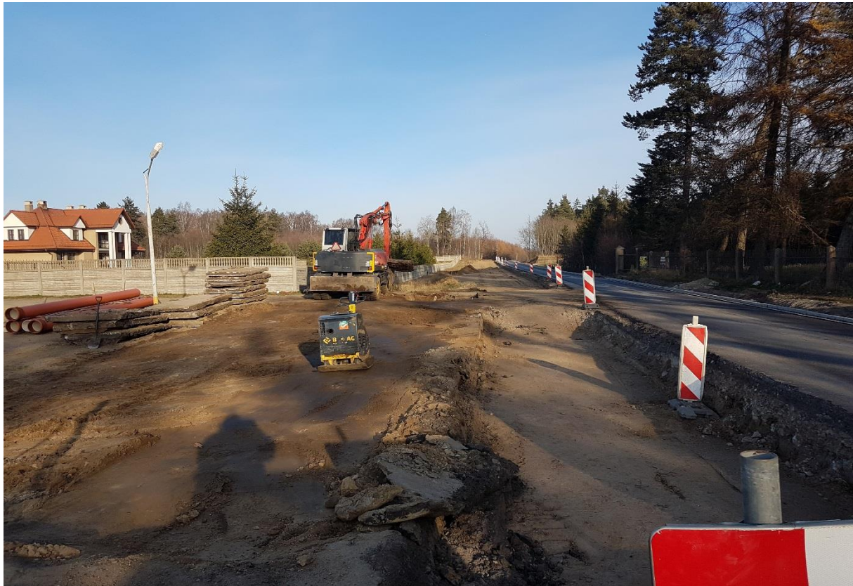
29.11.2018 Odc. C Roboty drogowe km 1+200
