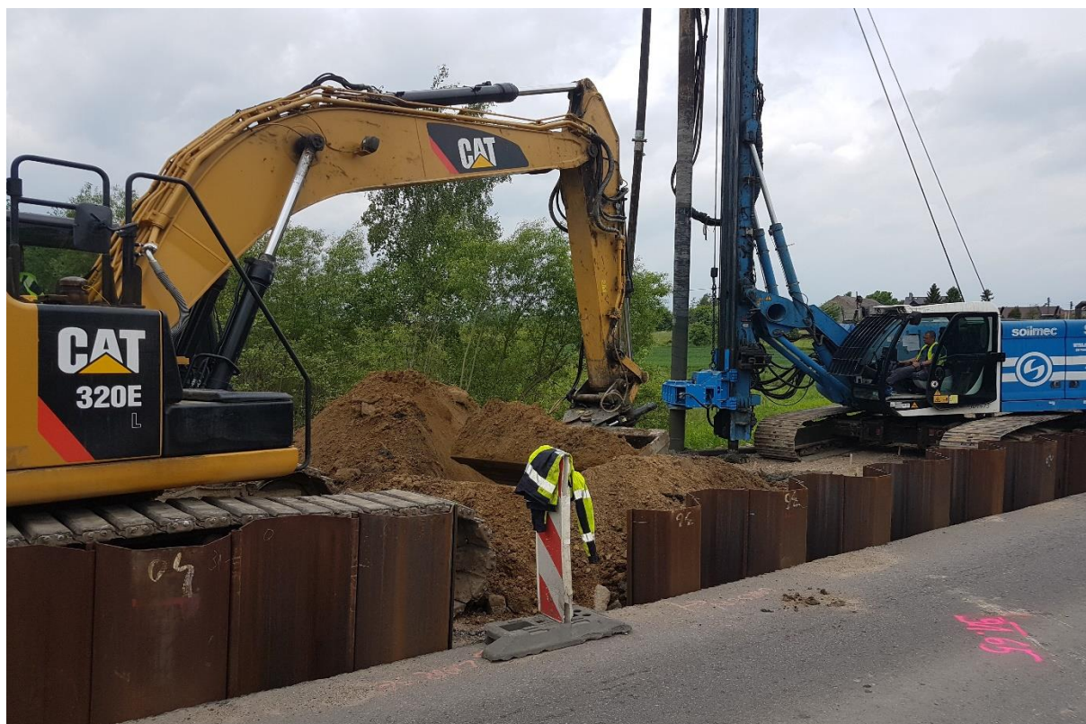
31.05.2019 Odc. C Wykonywanie wgłębnego wzmocnienia podłoża gruntowego
