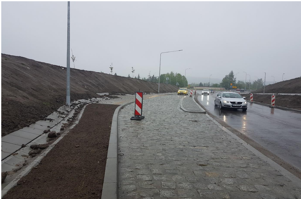
31.05.2019 Odc. E Roboty brukarskie, korytka ściekowe
