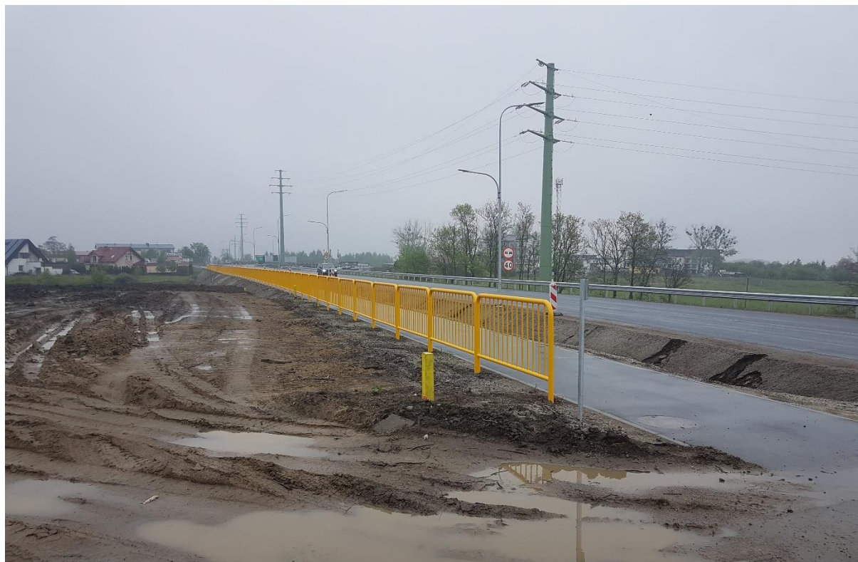
31.05.2019 Odc. A Montaż balustrad U-11a oraz świadków "pas drogowy"
