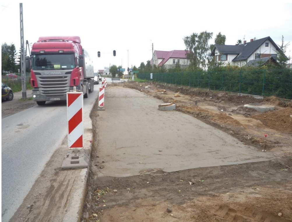
05.10.2017r. Odc. C. Przepust(Most) rejon wylotu. Wykonana stabilizacja cementem 18cm.
