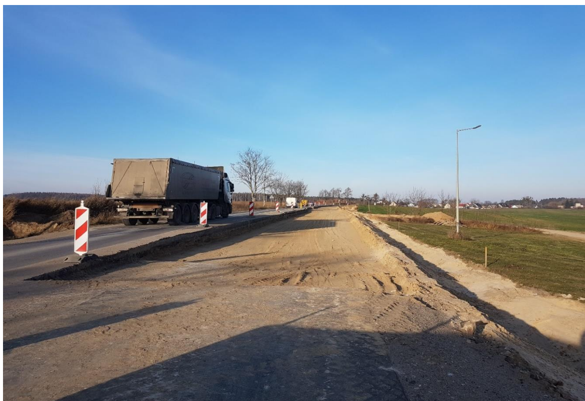
29.11.2018 Odc. C Roboty drogow km 2+600
