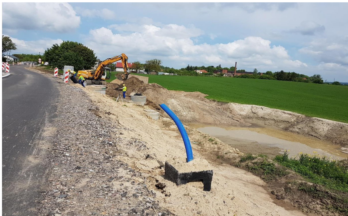
31.05.2019 Odc. C Roboty branżowe
