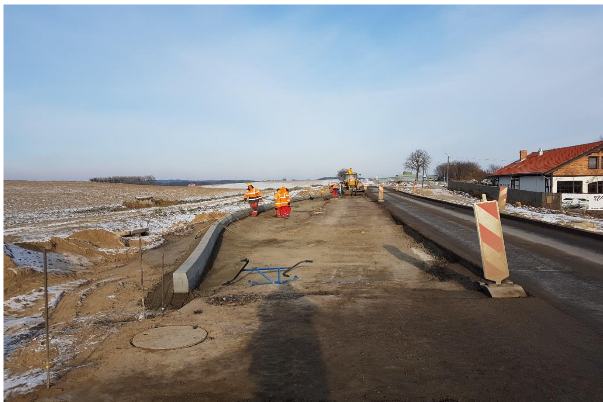
29.11.2018 Odc. E Roboty brukarskie
