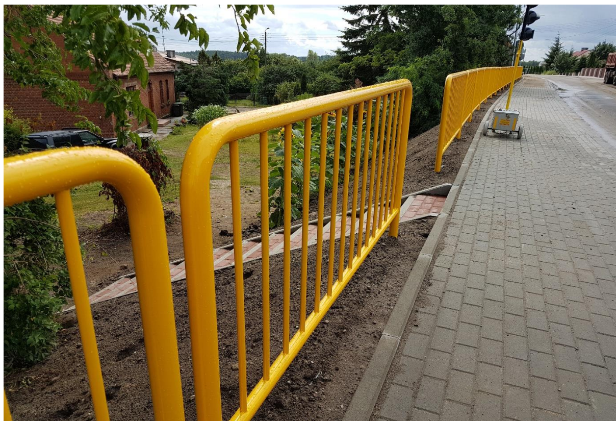
31.08.2019 Odc. D Montaż barier U-11a, wykonanie schodów terenowych
