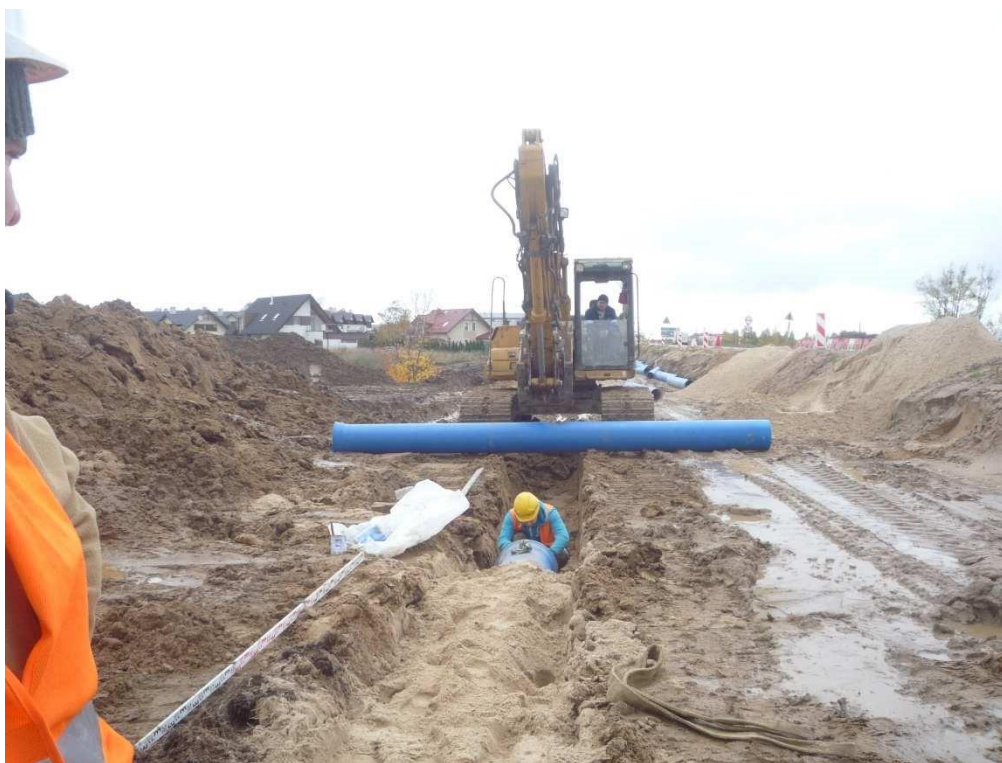
26.10.2017r. Odc. A. km 0+260. Kontynuacja budowy wodociągu Ø 400mm.
