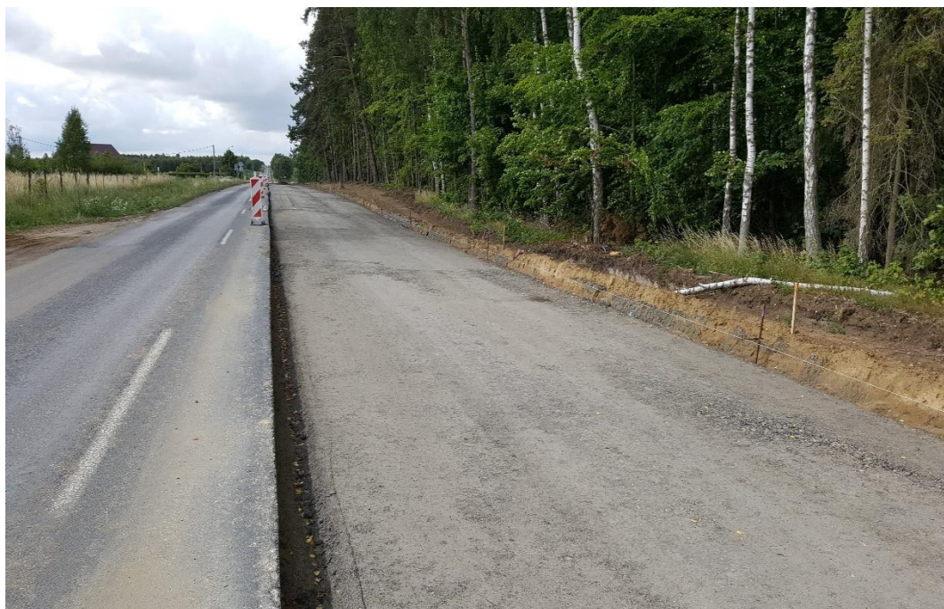
30.06.2018. Odc. B Roboty drogowe w km 2+600
