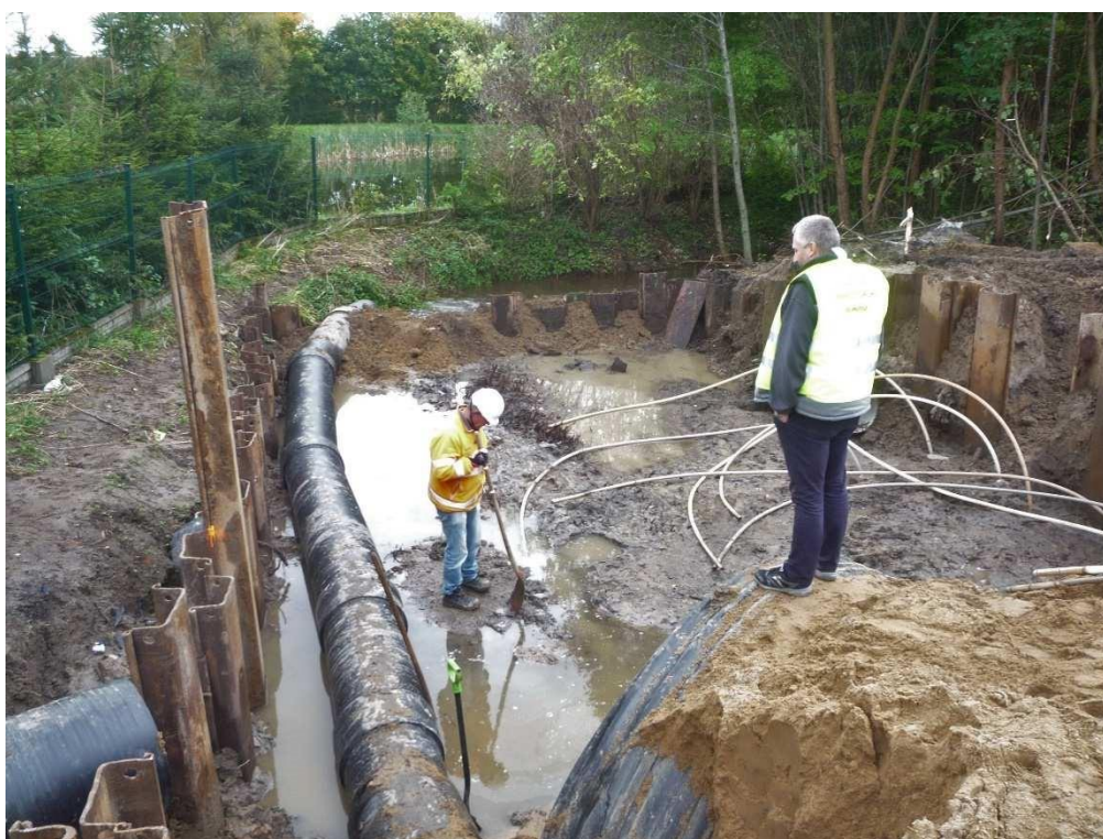
11.10.2017r. Odc.C. 0+050. Kolidzja kabla teletechnicznego z gabionami przy wylocie przepustu.
