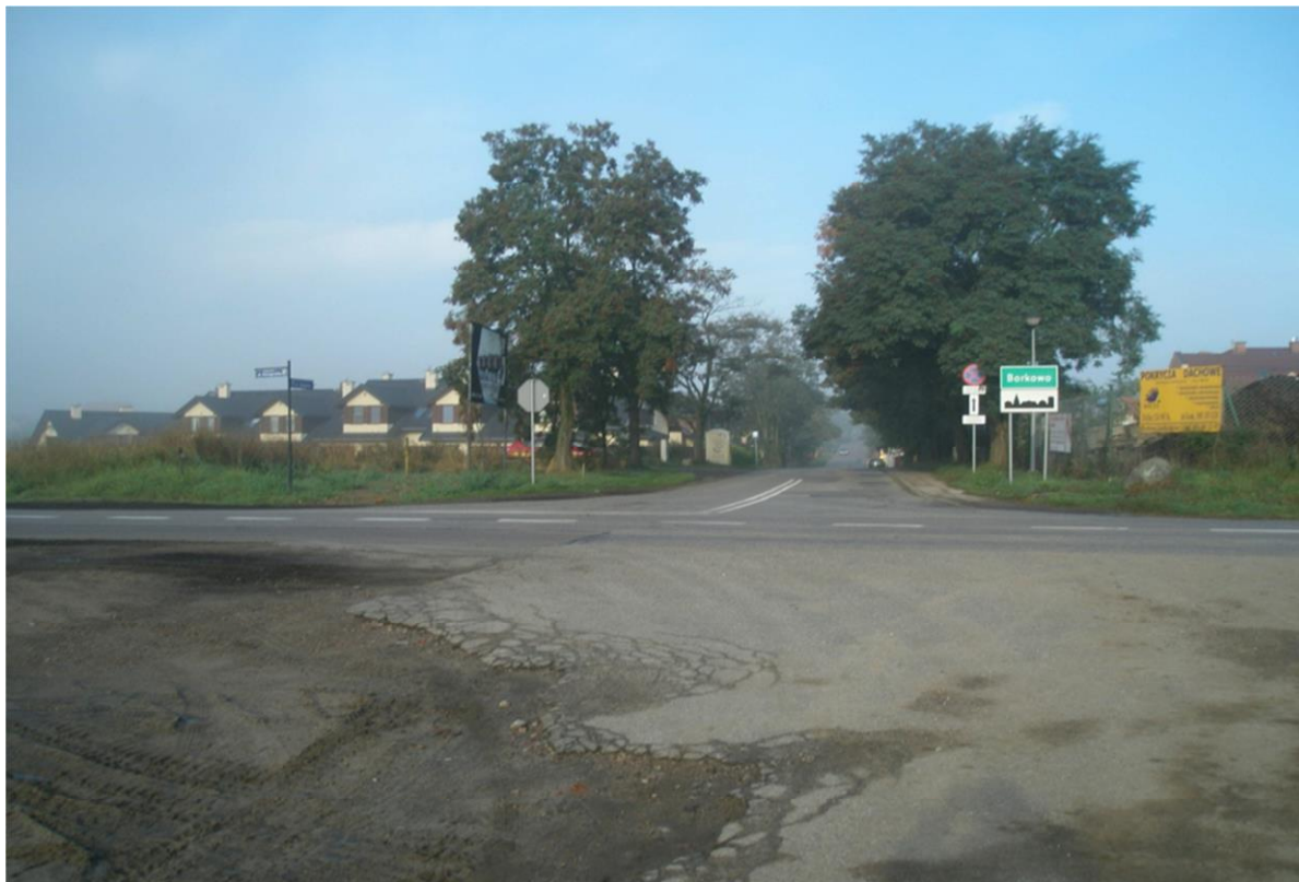
Fotografia 2 Uszkodzenia nawierzchni DW 222
