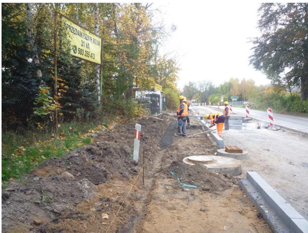
19.10.2017r. Odc. C. 0+550. Roboty przygotowawcze pod ustawianie obrzeża pod chodnik.
