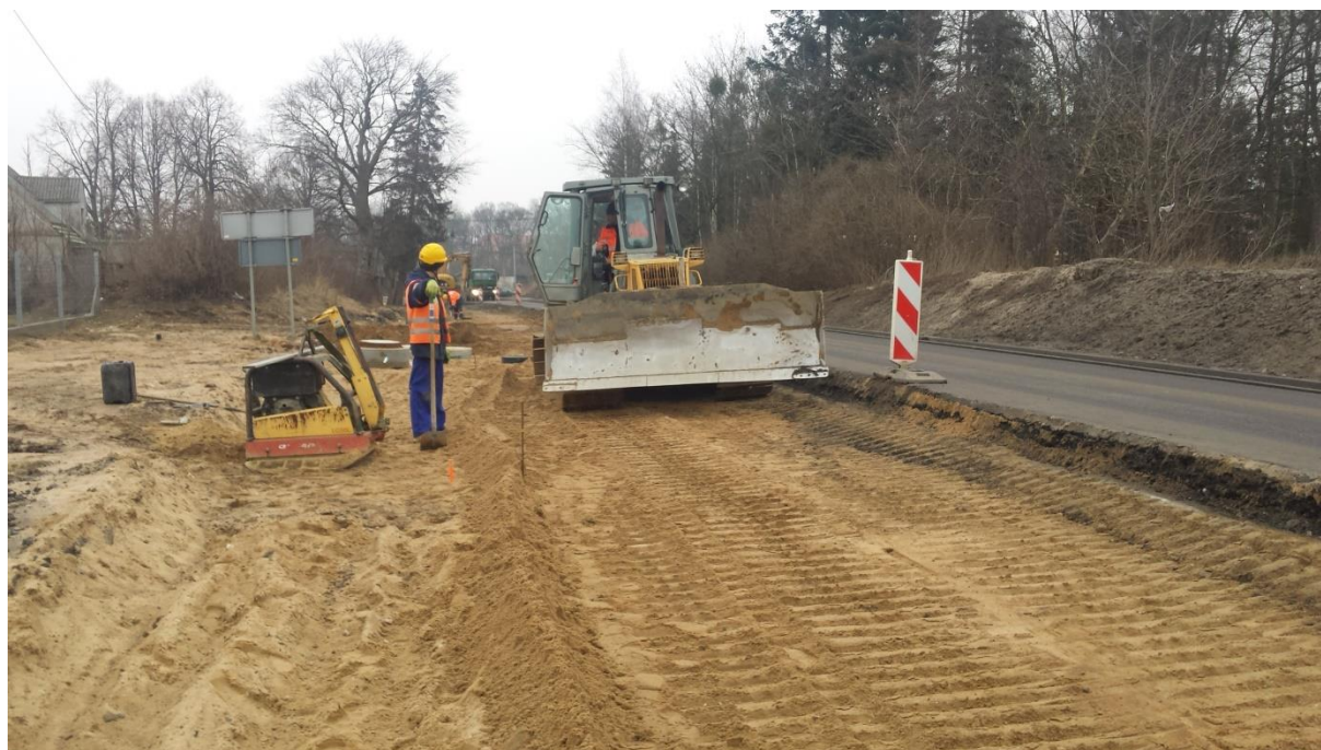
26.03.2018 r. Odc. E Roboty drogowe w km 0+000 do 0+650
