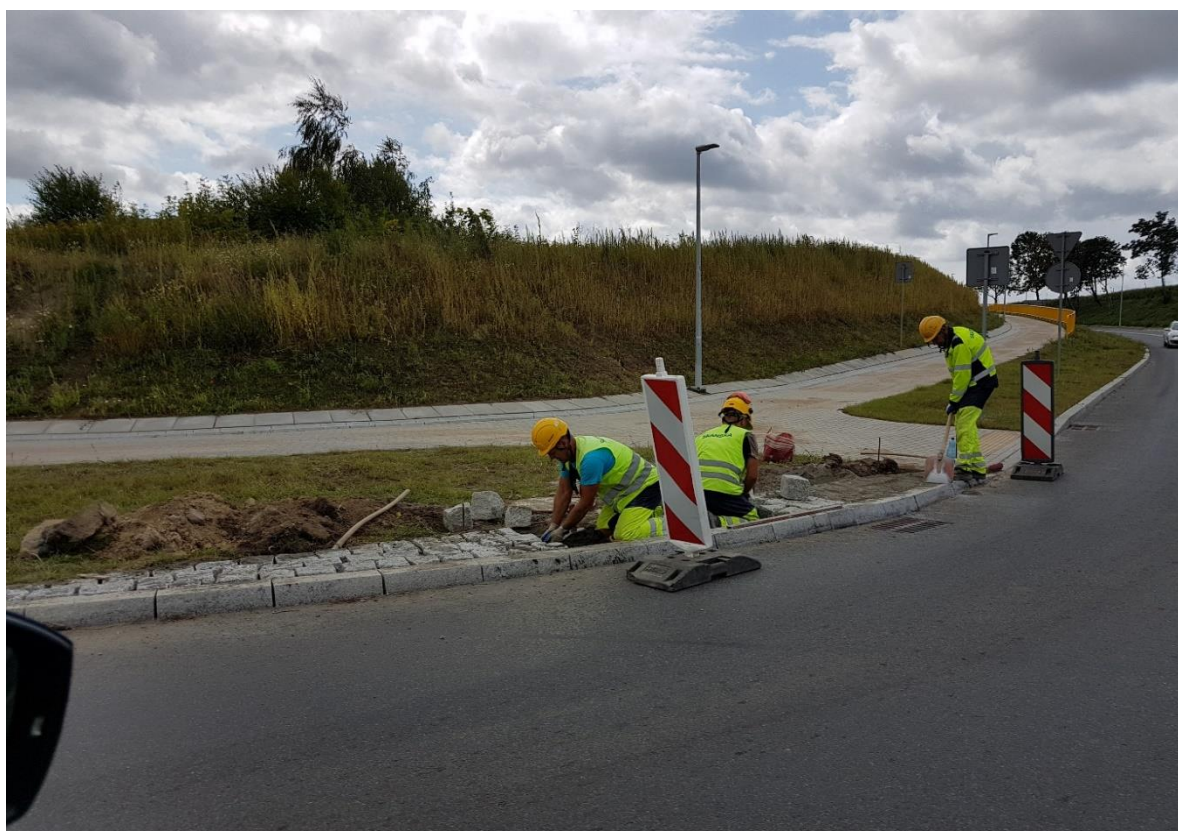
31.08.2019 Odc. E Roboty brukarskie ODCINEK „F”
