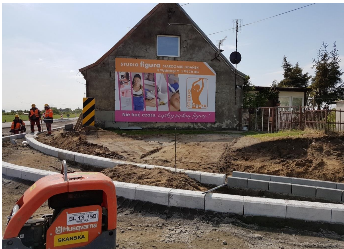
31.05.2019 Odc. C Roboty brukarskie
