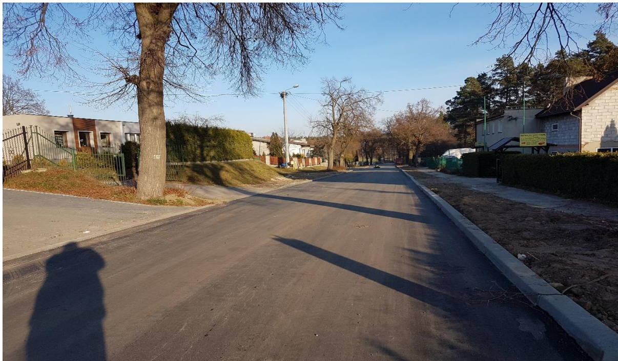
29.11.2018 Odtworzenie warstw konstrukcyjnych drogi powiatowej w m. Kokoszkowy wraz z ułożeniem nawierzchni
