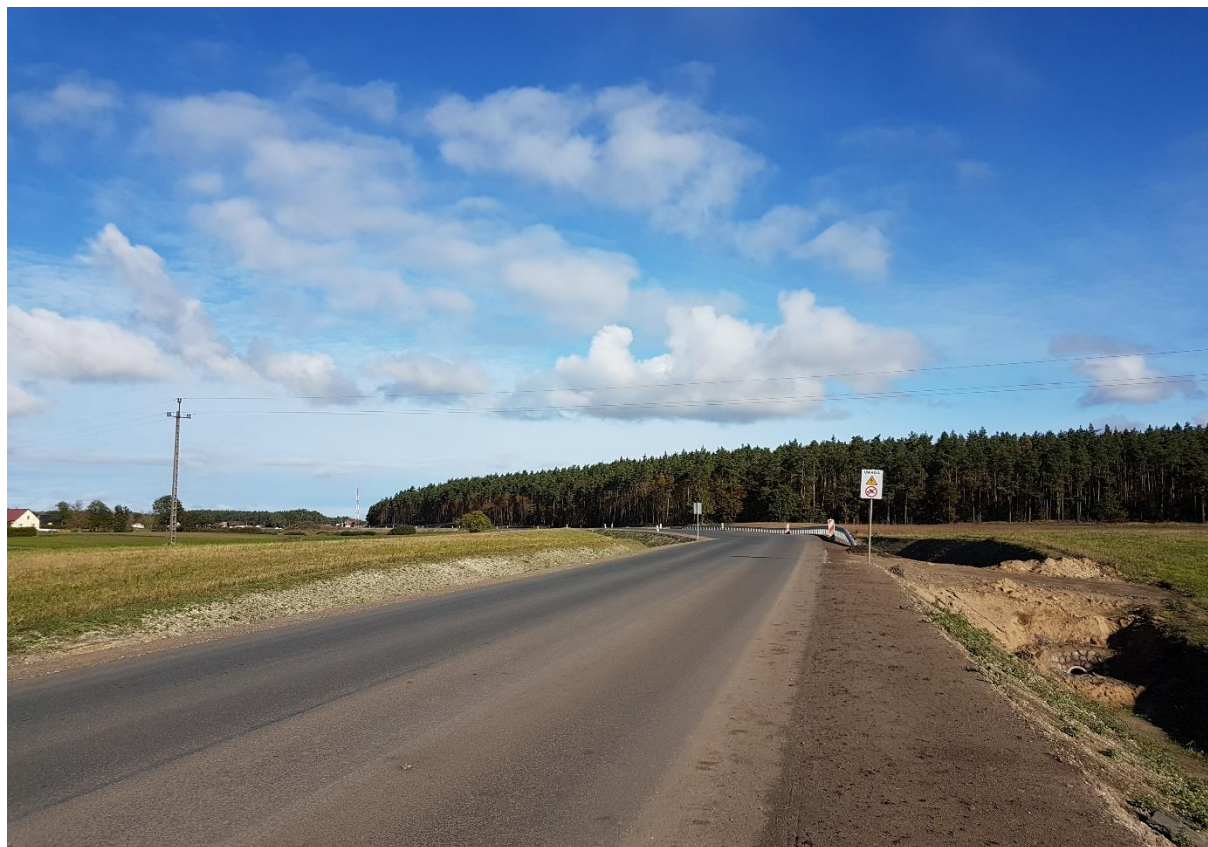
31.10.2019 Odc. D wykonywanie poboczy, profilowanie skarp, obsiew ODCINEK „E”
