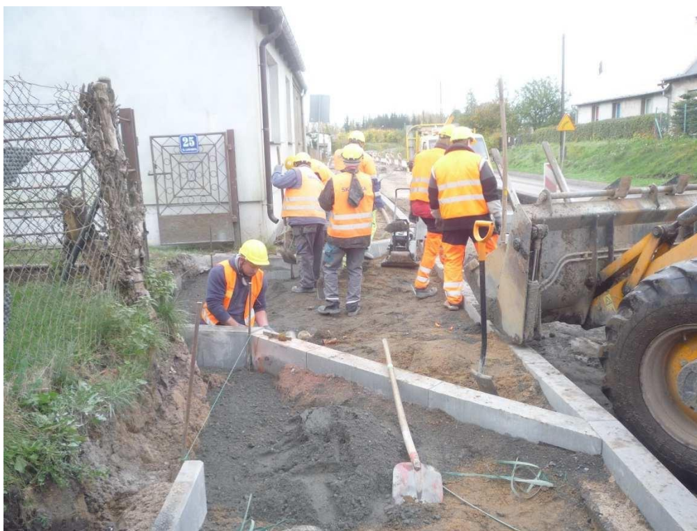
26.10.2017r. Odc. C. 0+240. Wykonywanie wjazdu.
