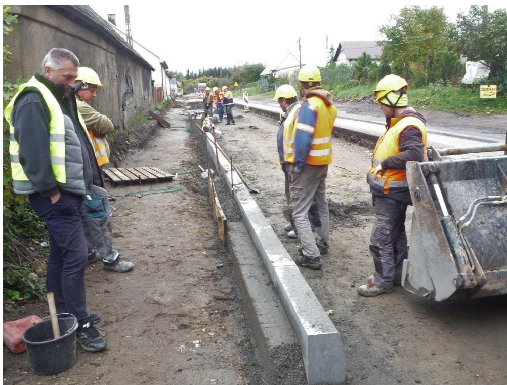
11.10.2017r. Odc.C. 0+200 Ustawianie krawężnika ulicznego w m. Gołębiewo WLK.
