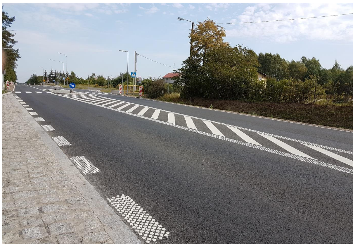
31.08.2019 Odc. B Wykonanie oznakowania poziomego
