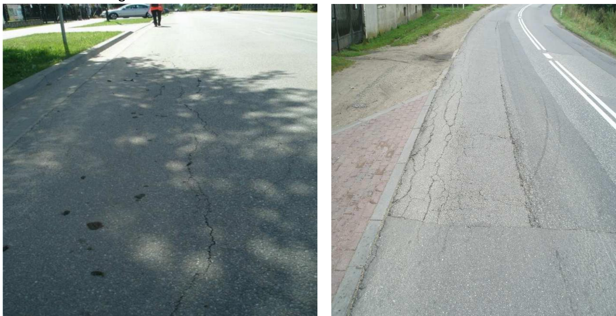
Fotografia 2 Uszkodzenia nawierzchni DW 222
