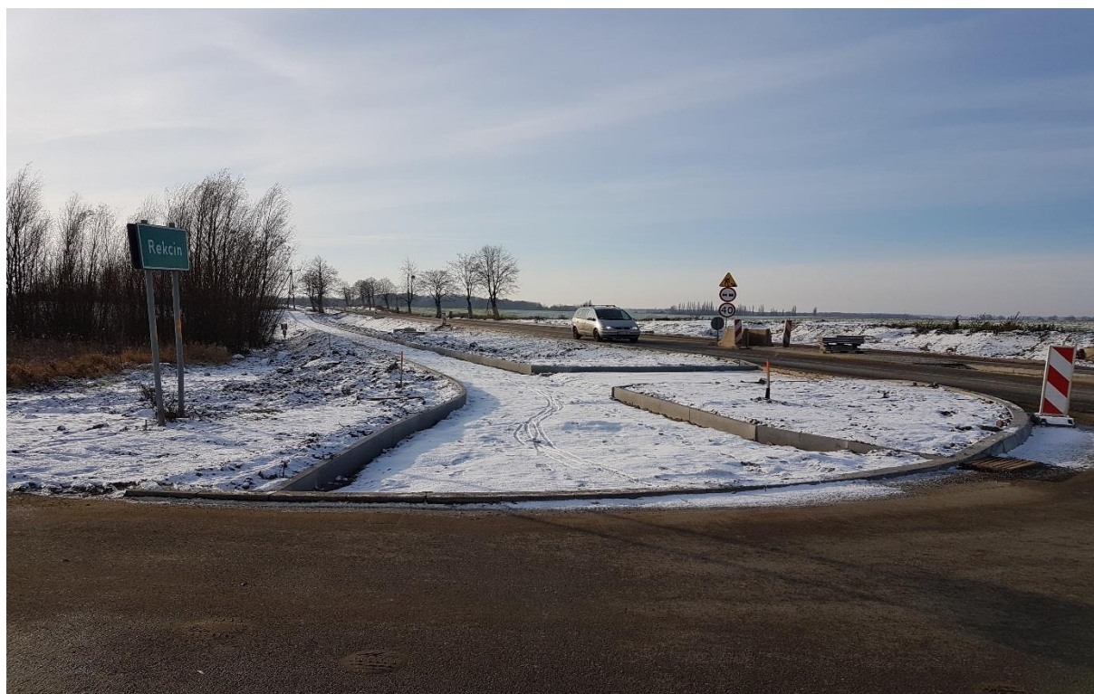
29.11.2018 Odc. E Roboty brukarskie- przygotowanie do wykonania nawierzchni ścieżki
