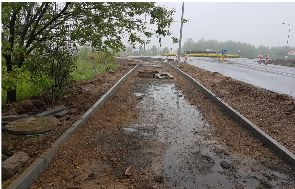
31.05.2019 Odc. F Roboty brukarskie
