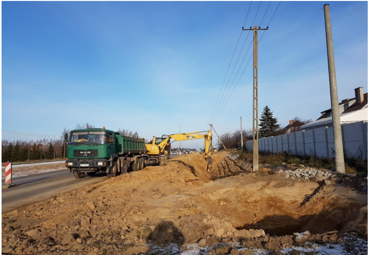
29.11.2018 Odc. B Roboty ziemne km 3+610
