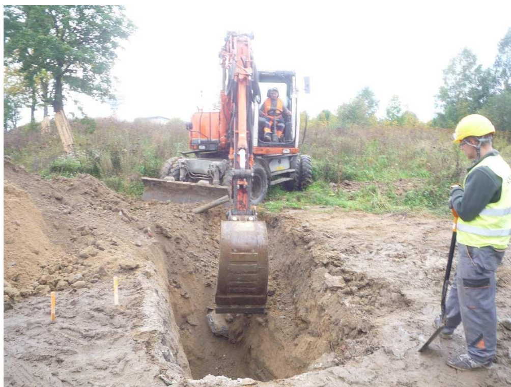
02.10.2017r. Odc. A. Przepust PD 2. Powtórne zagęszczanie nasypu pod ścieżkę w rejonie wlotu.
