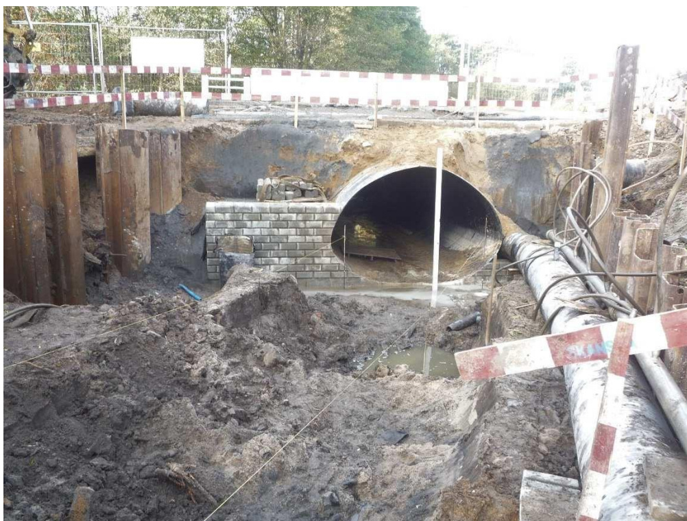
17.10.2017r. Odc. C. 0+067. Roboty przy wylocie przepustu.
