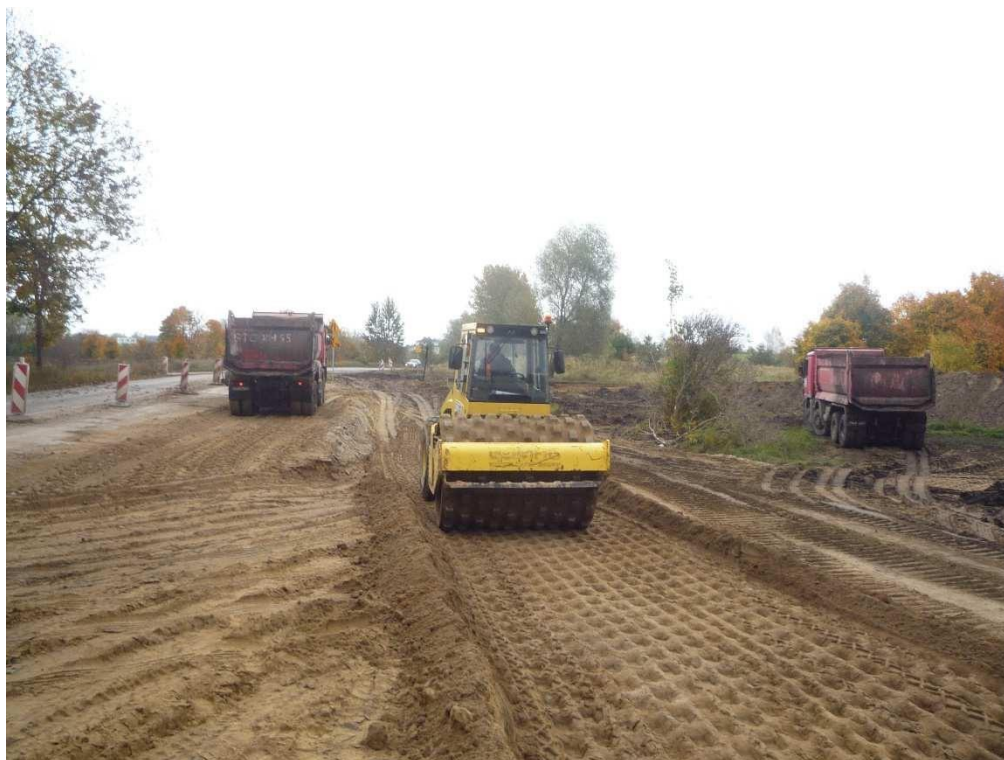
19.10.2017r. Odc. D. 3+500. Nasyp po wymianie gruntu.
