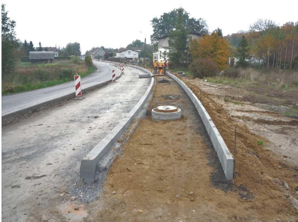
20.10.2017r. Odc. C. Gołębiewo WLK. Ustawiony krawężnik betonowy ul. i obrzeże.
