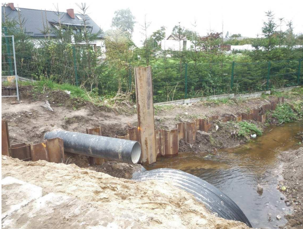
05.10.2017r. Odc. C. Przepust(Most). Wbite ścianki szczelne w rejonie wylotu.
