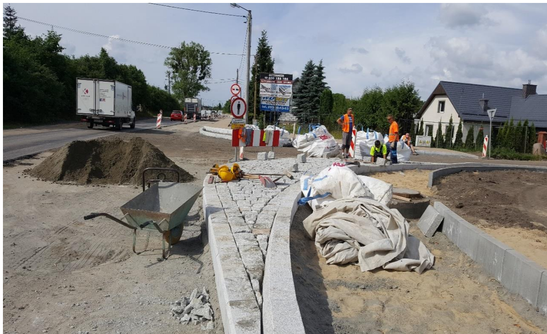
30.06.2018 r. Odc. C Układanie kostki kamiennej km 1 + 300
