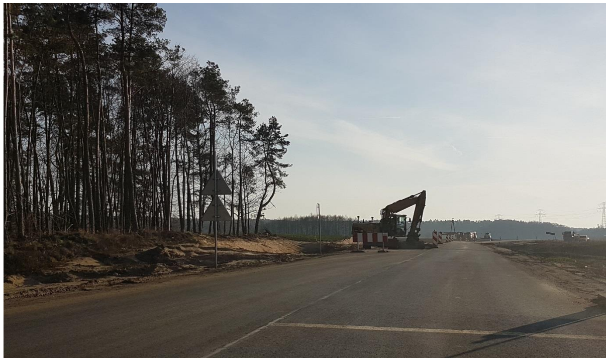
29.11.2018 Odc. D Roboty drogowe, ułożona warstwa wiążąca km 6+230
