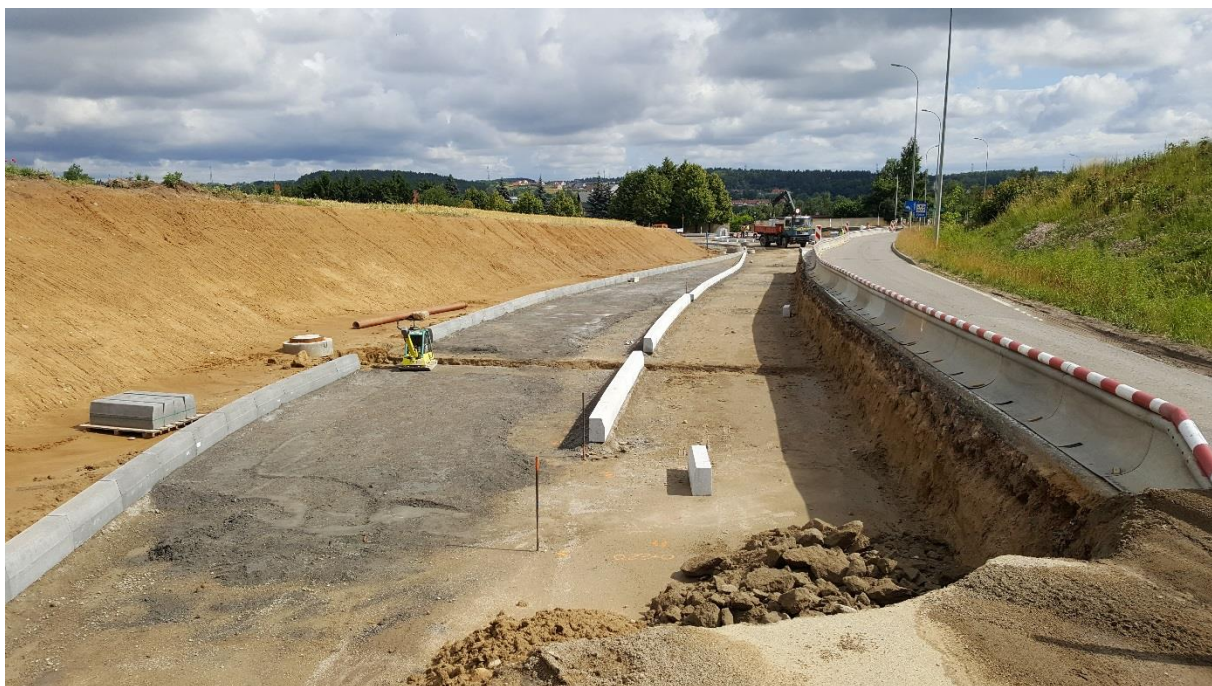
30.06.2018 r. Odc. E Roboty drogowe km 0+200
