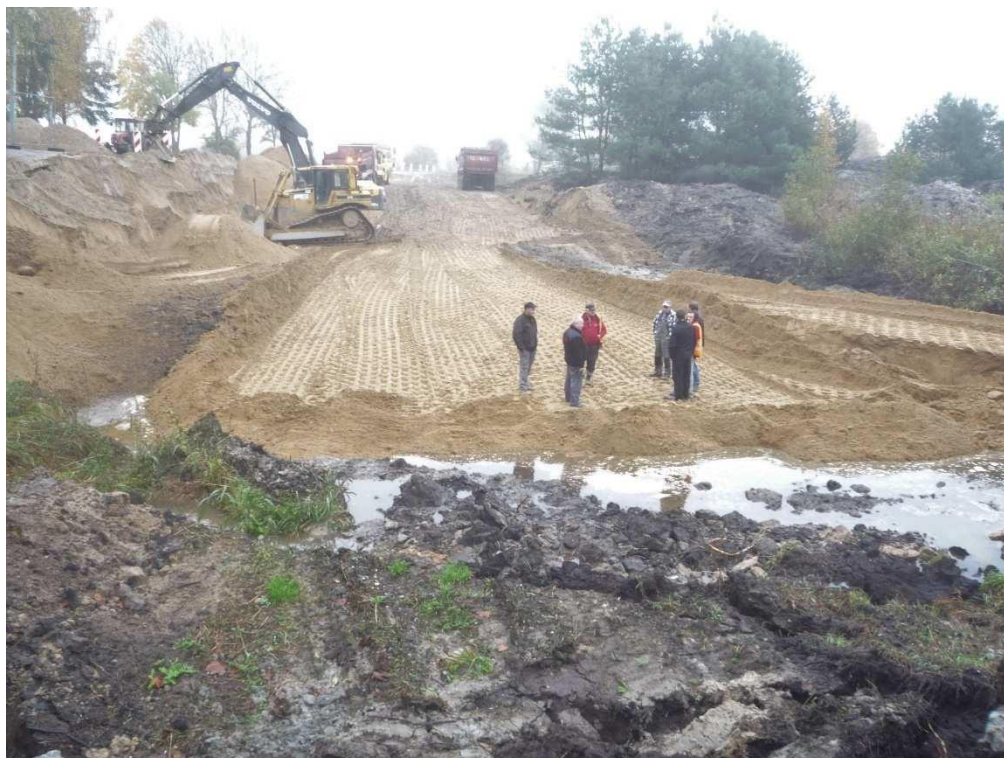
24.10.2017r. Odc. D 3+560 . Rejon wymiany gruntu. Do wymiany gruntu pozostało około 7m.
