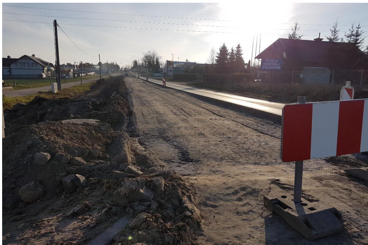
29.11.2018 Odc. D Roboty drogowe km 13+240
