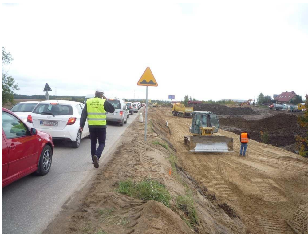
05.10.2017r. Odc. A. Budowa nasypu pod ścieżkę przy ul. Akacjowej.
