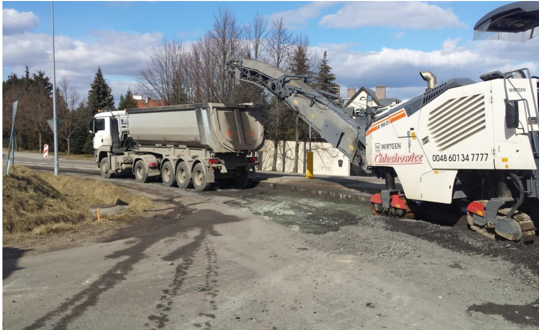
26.03.2018 r. Odc. C Rozbiórka istniejącej nawierzchni w km 0+000 - 0+300; 1+000 - 1+100; 2+200 - 3+020
