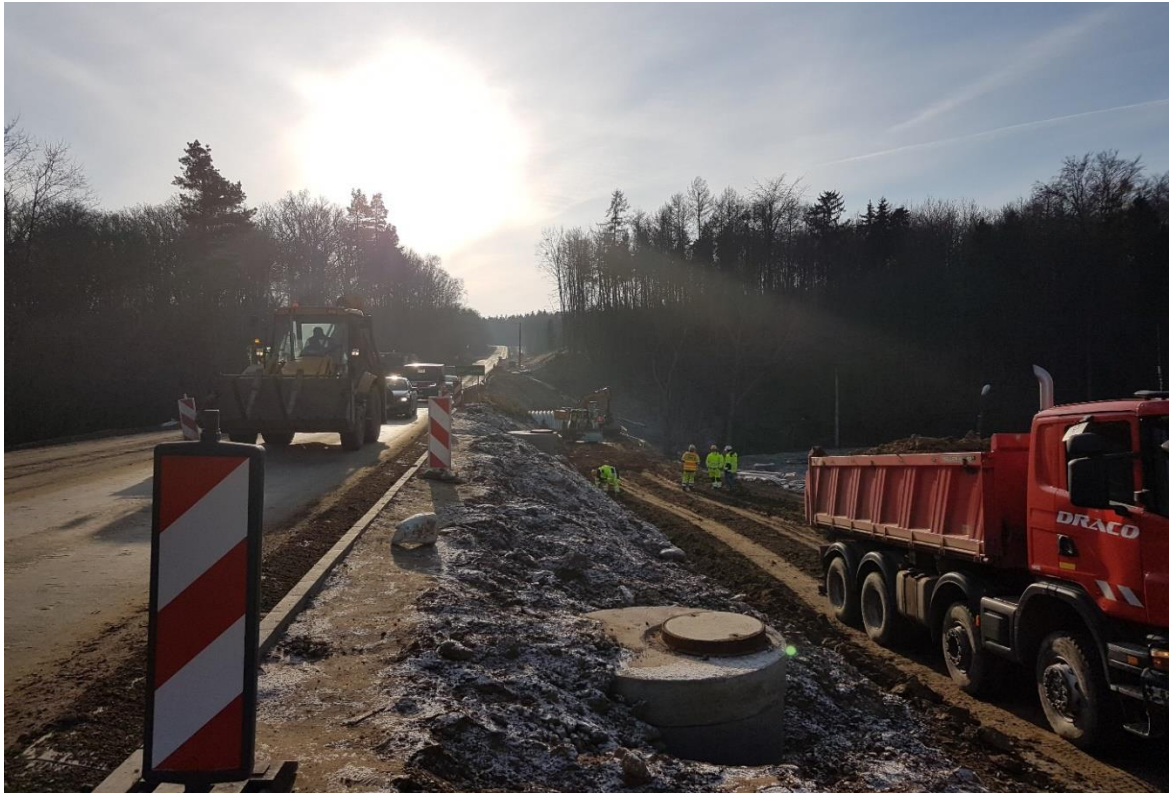
29.11.2018 Odc. B Roboty przy obiekcie mostowym w Kleszczewie, roboty drogowe km 5+300
