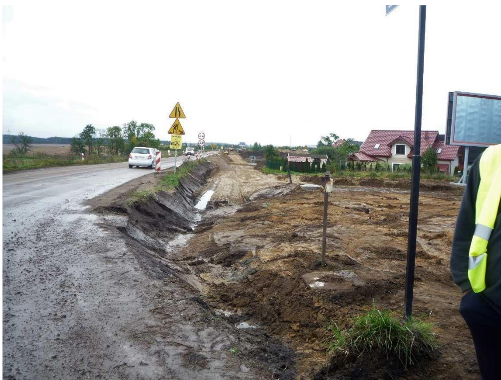
03.10.2017r. Odc. A. Roboty od ul. Akacyjnej w Borkowie.
