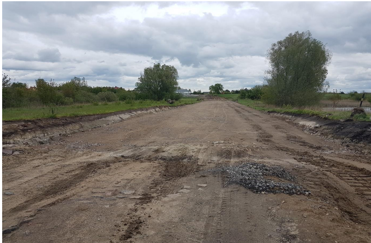
31.05.2019 Odc. D Wykonywanie platformy roboczej pod palownicę
