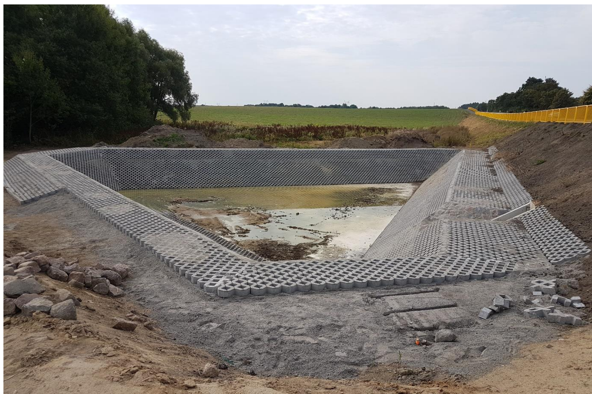
31.08.2019 Odc. B Roboty związane z budową zbiornika retencyjnego
