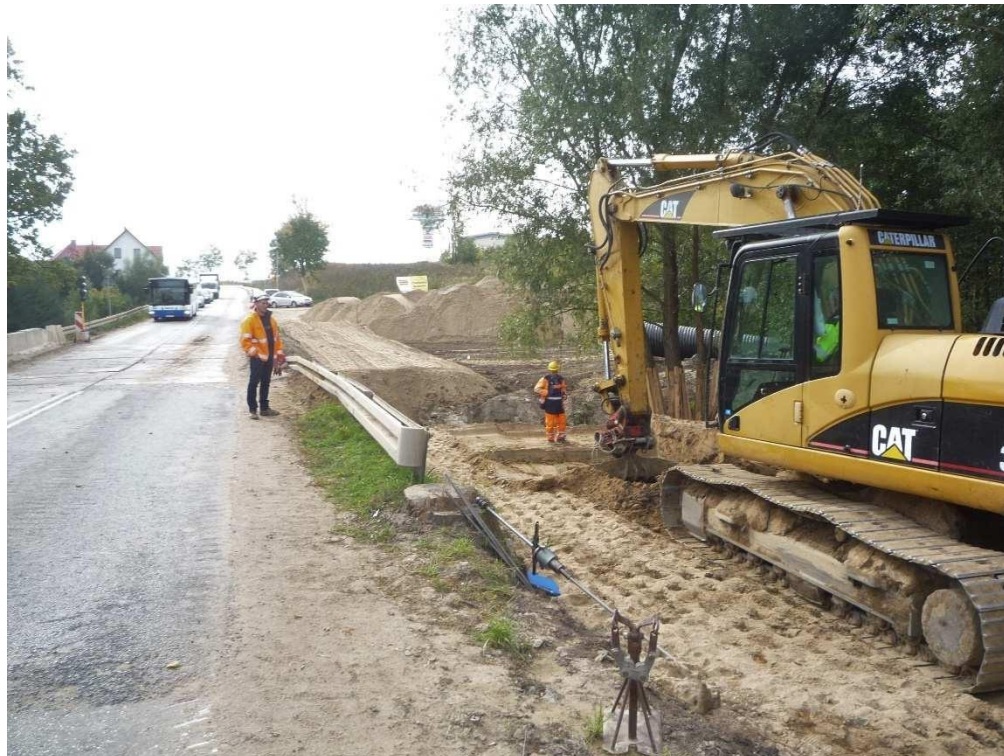
02.10.2017r. Odc. A. Przepust PD 2. Powtórne zagęszczanie nasypu pod ścieżkę w rejonie wlotu.
