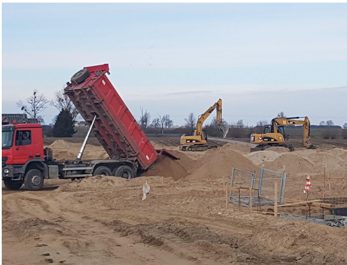
26.03.2018 r. Odc. D Roboty związane z wymianą gruntów w m. Siwiątka
