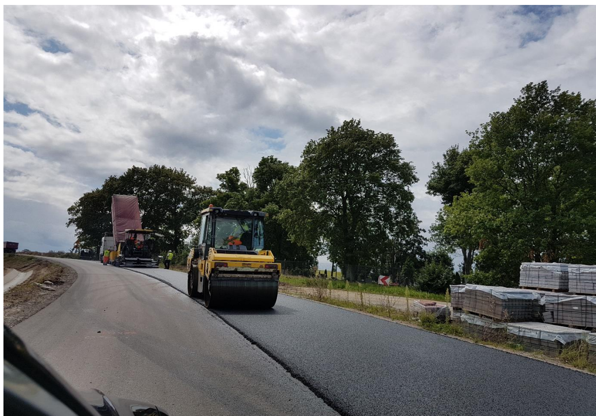
31.08.2019 Odc. D Ułożenie warstwy ścieralnej
