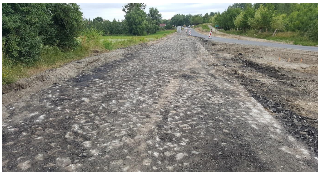
30.06.2018 r. Odc. D Roboty rozbiórkowe km 0 + 100
