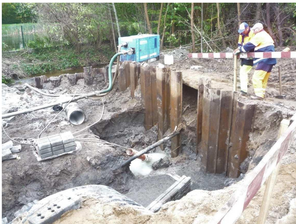
14.10.2017r. Odc. C. 0+067. Roboty betonowe, osuszanie gruntu i kabel światłowodowy na wylocie Przepustu.
