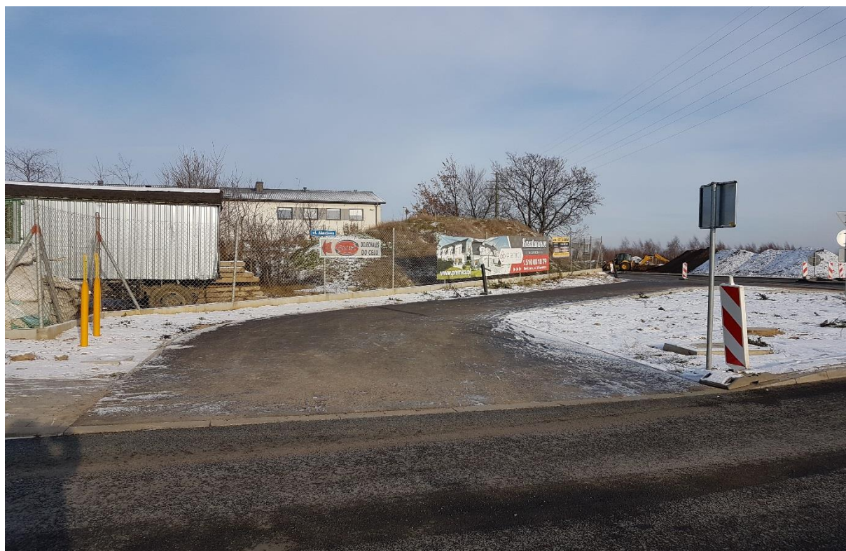
29.11.2018 Odc. A Ułożona nawierzchnia ścieżki rowerowej km 0+100
