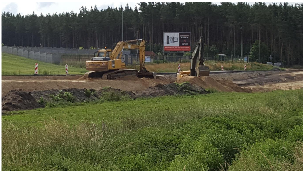
30.06.2018 r. Odc. D Roboty ziemne km 5+400
