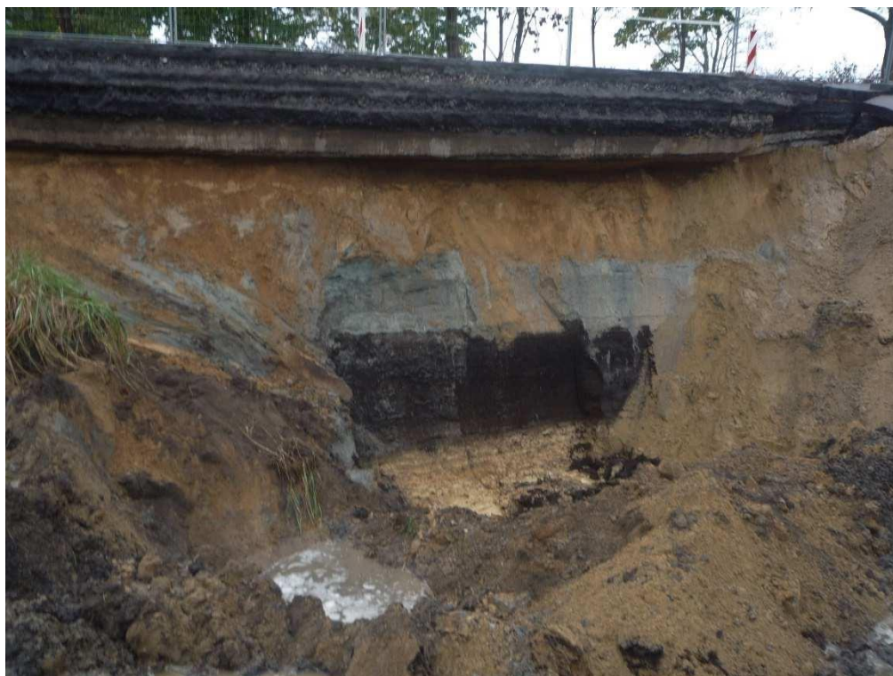
24.10.2017r. Odc. D 3+560 . Rejon wymiany gruntu. Wykop przy istniejącej jezdni. Przekrój warstw gruntowych.
