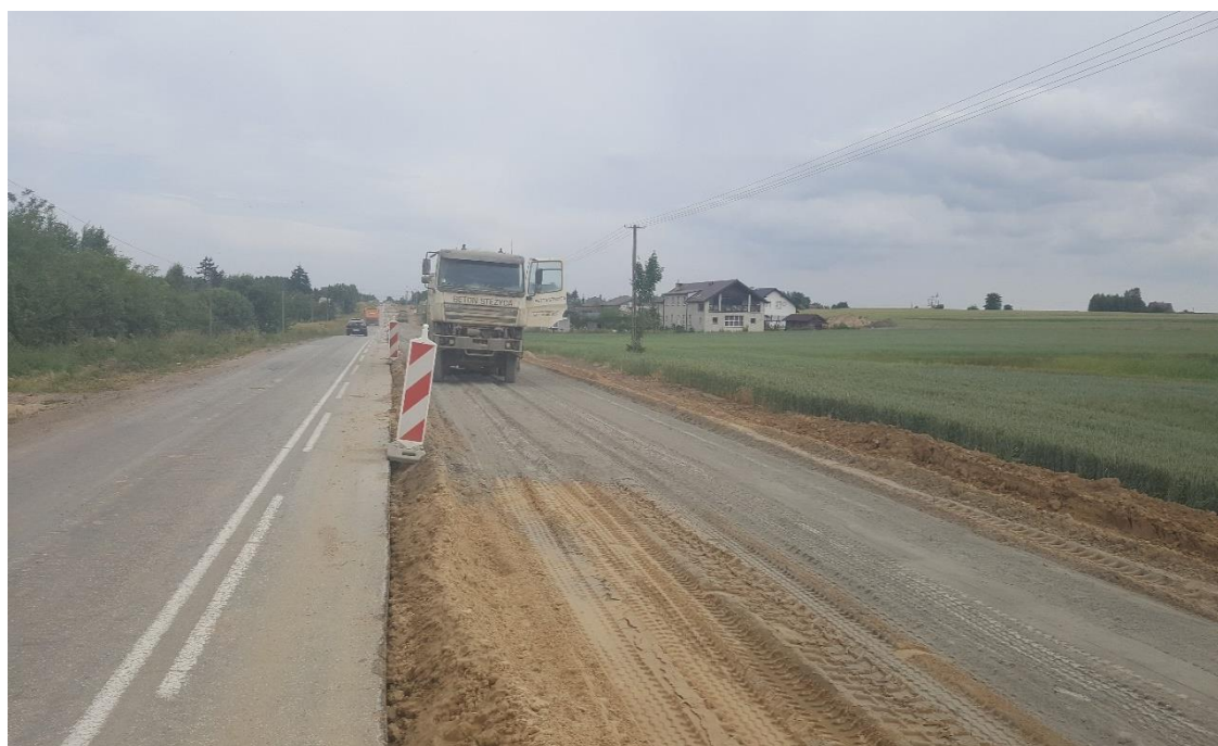
30.06.2018. Odc. B Osuszanie gruntu km 4+500
