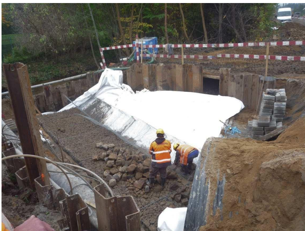
19.10.2017r. Odc. C. 0+067. Wykonywanie gabionów kamiennych na wylocie przepustu.
