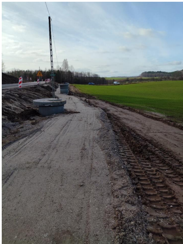
Budowa kanalizacji deszczowej.
