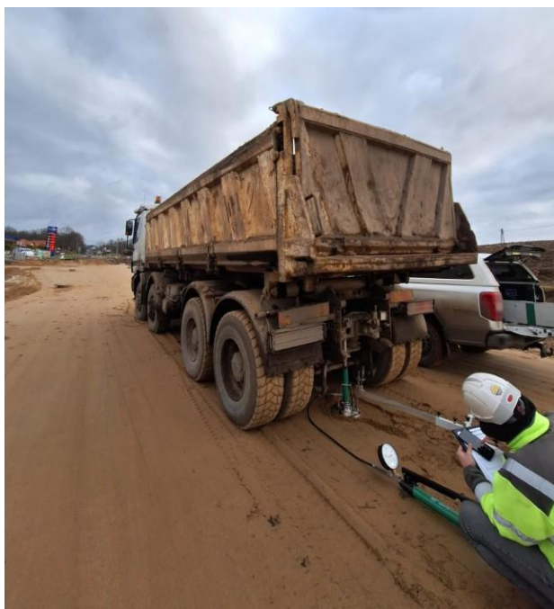
Badanie nośności po wymianie gruntów
