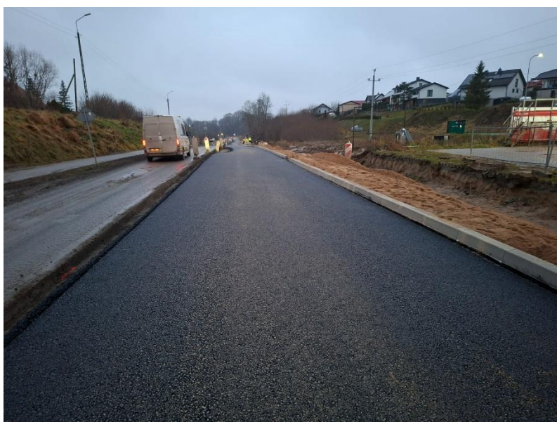
Wykonywanie podbudowy
